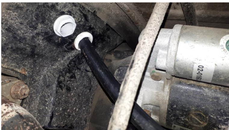
Kuva 23. Polttoaineletkujen läpivienti moottoritilaan
