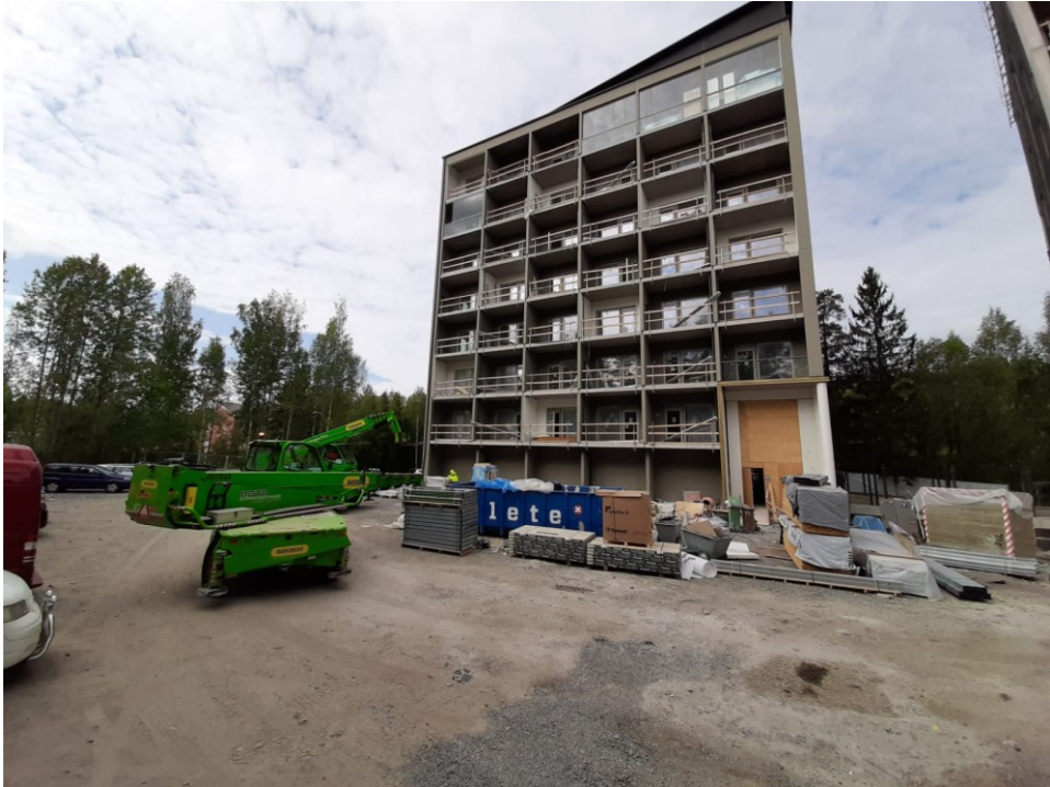
Kuva 4. Työmaalle vuokrattu kurottaja nostotöissä.
