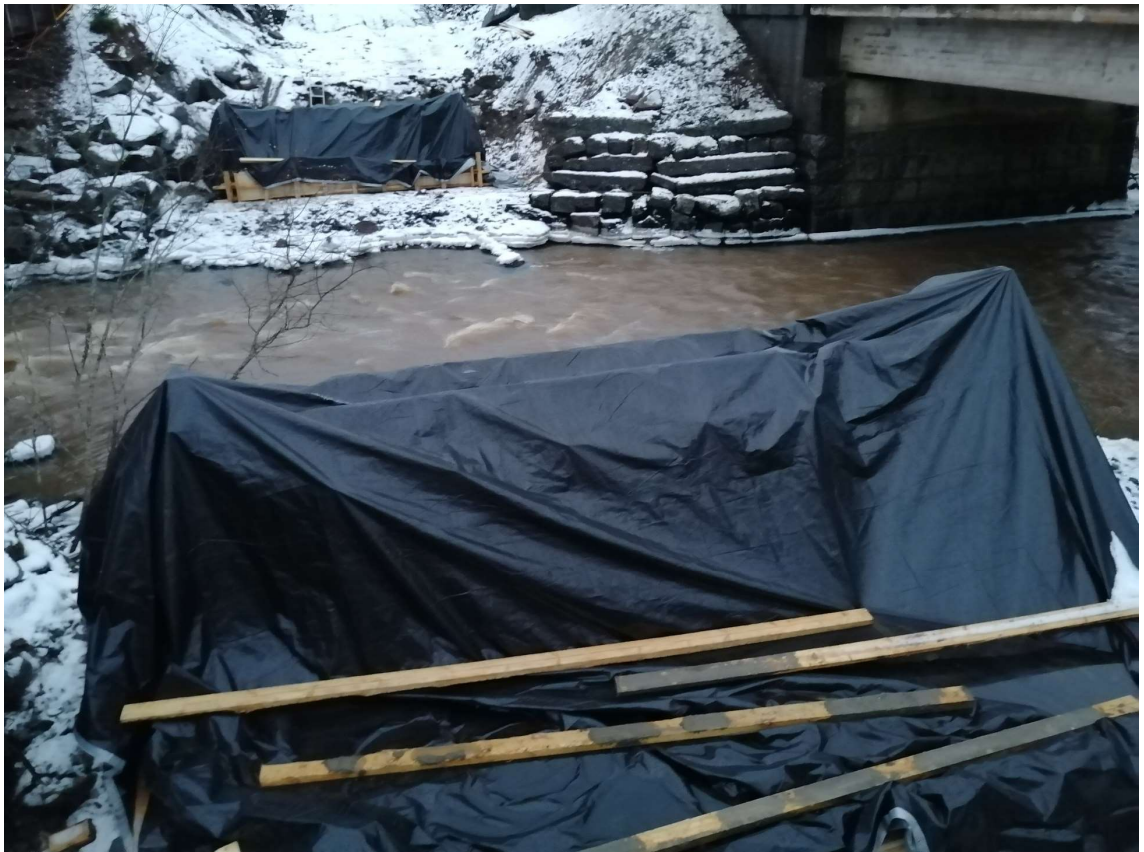
Kuva 9. Anturat suojattu pressuilla valun jälkeen
