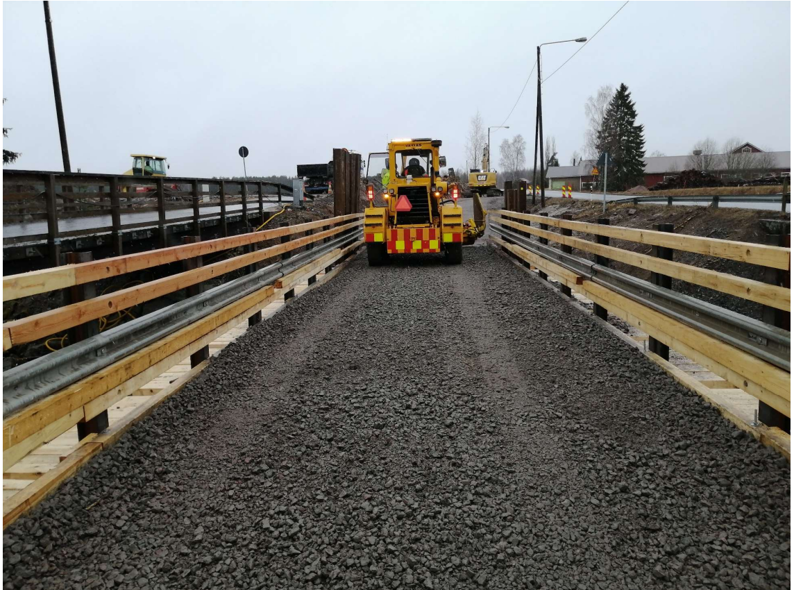
Kuva 15. Murskeen tasoittamista ja kaatojen tekemistä tasohöylällä
