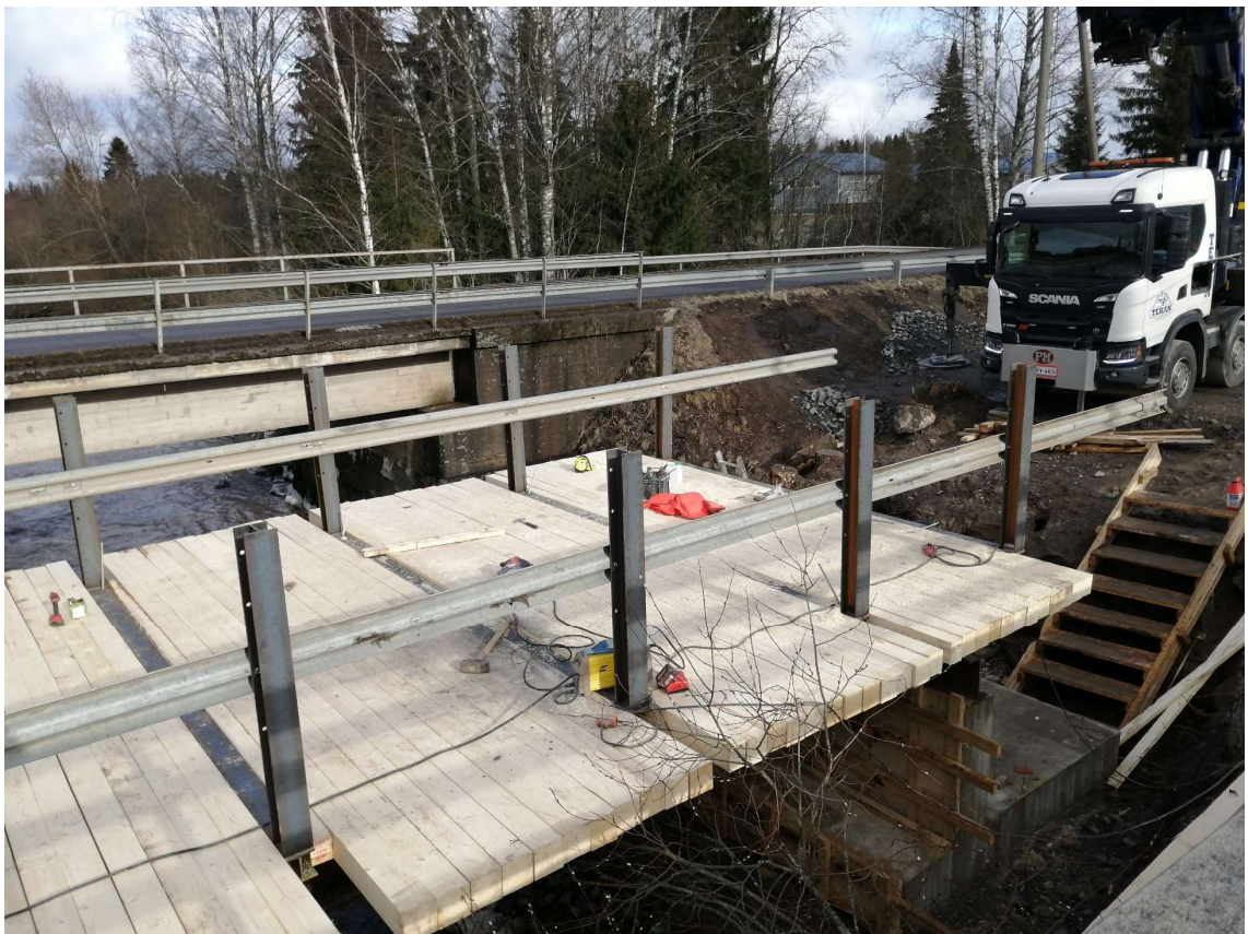
Kuva 14. Kannen pelkoitus, kaidetolpat ja teräksinen ajojohde
