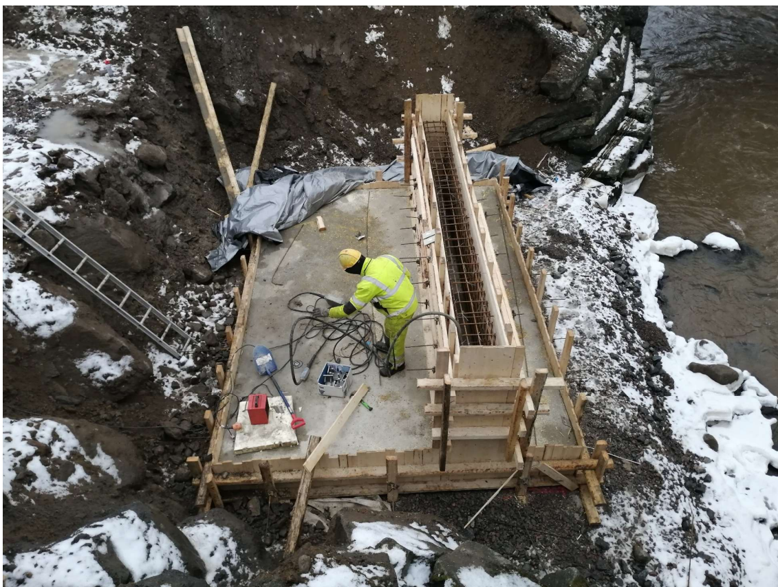
Kuva 8. Etumuuri valmiina betonivaluun
