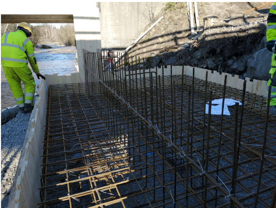
Kuva 6. Peruslaatan valmis raudoitus
