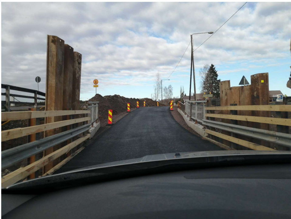
Kuva 18. Valmis varasilta lamelleineen
