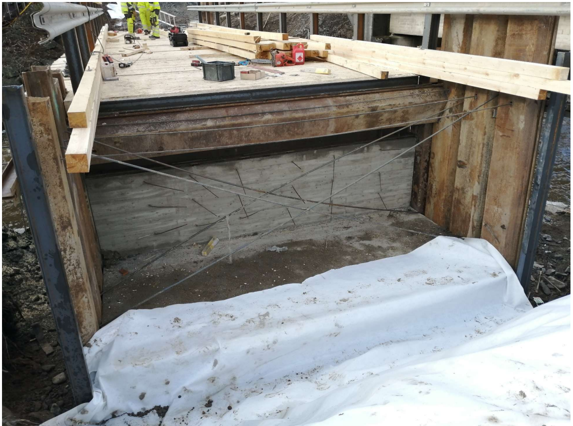
Kuva 10. Ponttiseinät ankkuroituna toisiinsa kiinni
