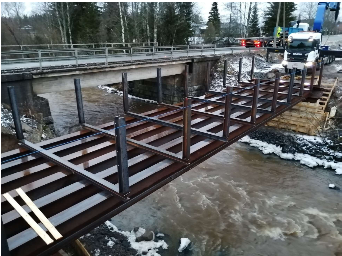
Kuva 13. Varasillan pääpalkit, poikkipalkit ja kaidetolpat asennettuna
