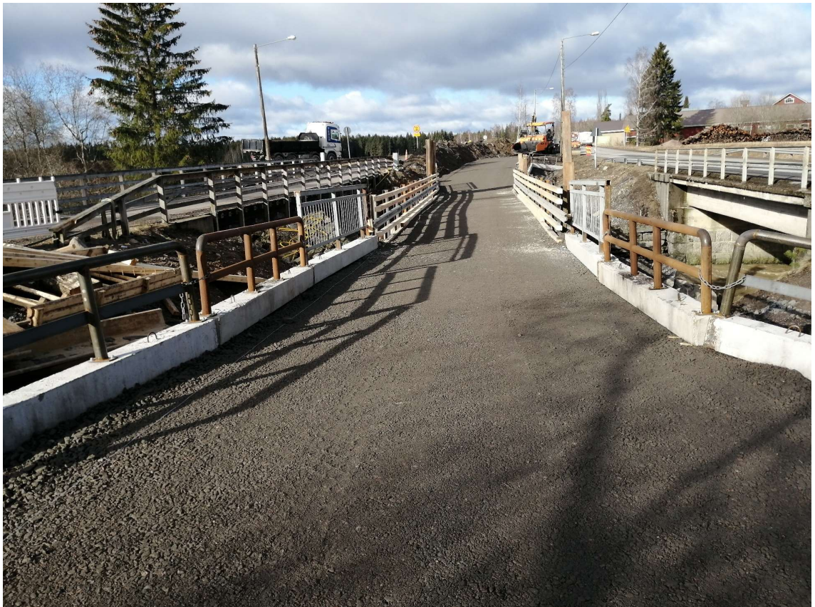
Kuva 16. Sillan kaiteita jatkettu raskasesteillä
