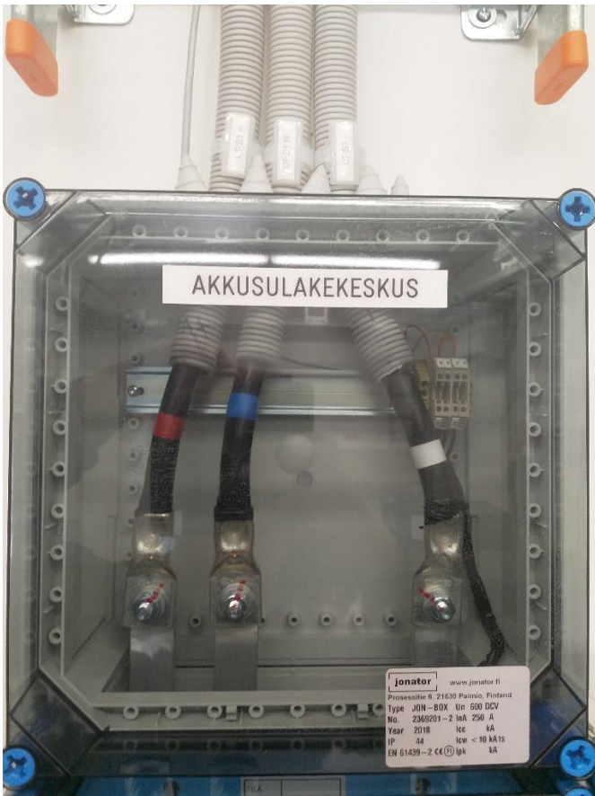
KUVA 8. Akuston napajännitteen mittauspisteet
