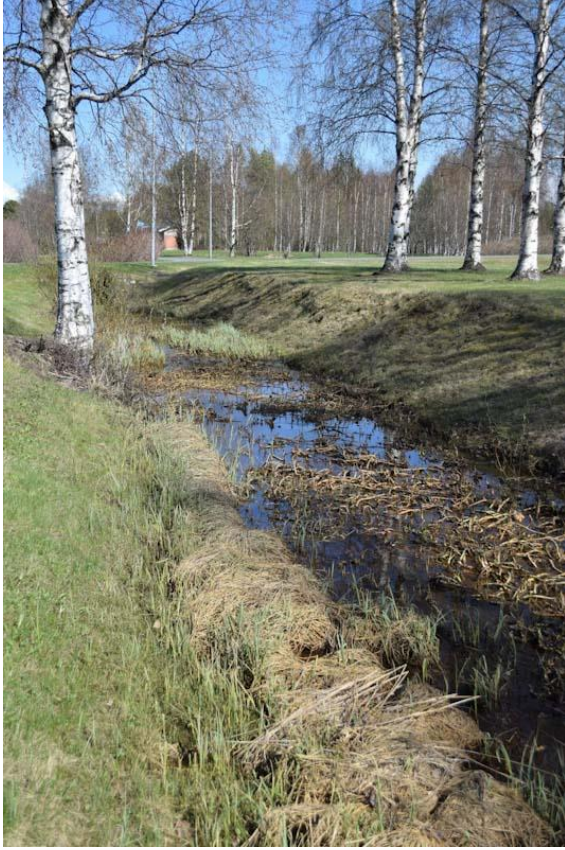
KUVA 31. Umpeenkasvanut ja reunoiltaan liian jyrkkä laskuoja
