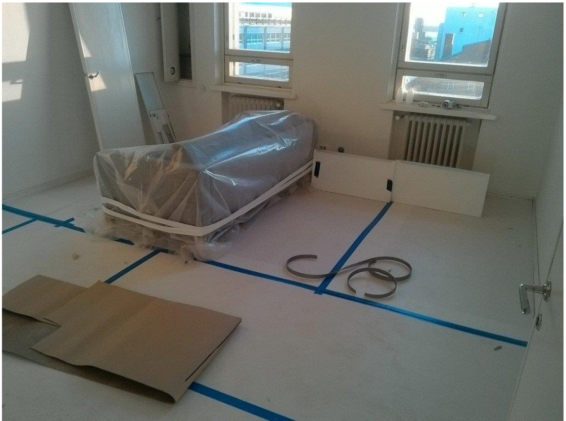
Kuva 3. Huoneiston suojaus (Asta Veikkanen 2019)
