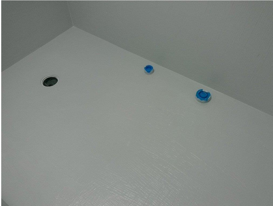
Kuva 8. Kylpyhuoneen vedeneristys (Asta Veikkanen 2019)
