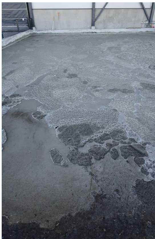
KUVA 2. Betonilietteen saapumisesta kulunut 1 vuorokausi (Laura Mikkola 2020)
