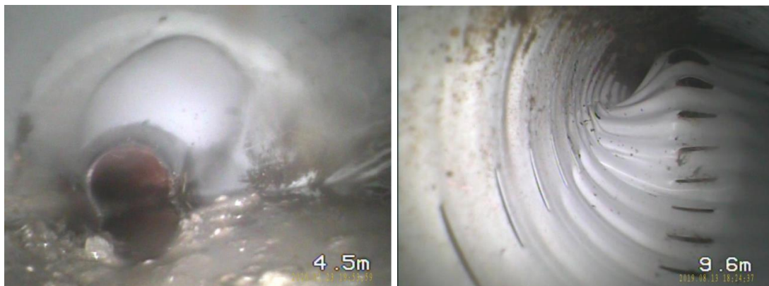
Kuva 2. Putkissa havaittuja vaurioita (KT Kuntotutkimus Oy)
