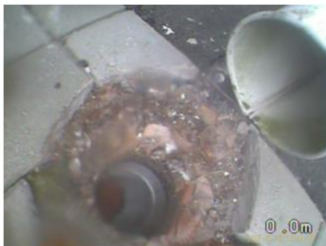
Kuva 1. Syöksytorvelta lähtevä sadevesiviemäri. Sadevesisuppilo poistettu kuvauksen ajaksi.
