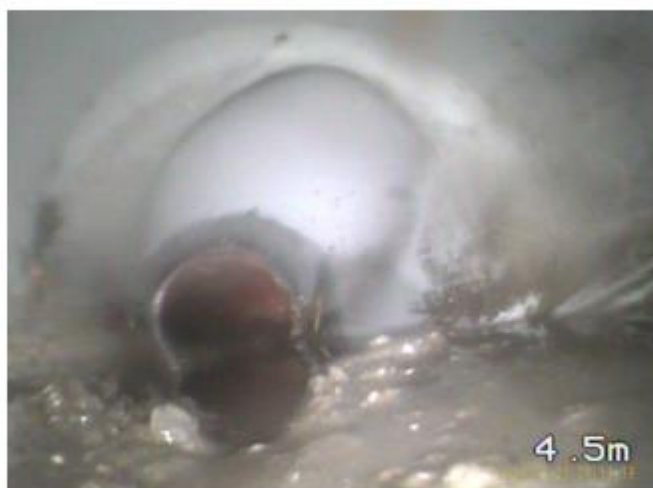
Kuva 2. Sadevesiviemärissä havaittua maa-ainesta.
