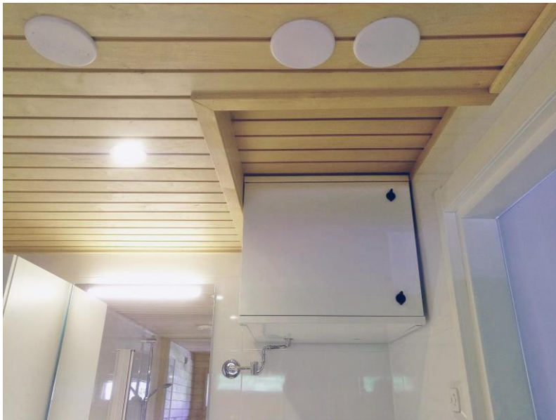
KUVA 12. Ilmanvaihtokoneelle tehty syvennys (Luttinen, 2020)
