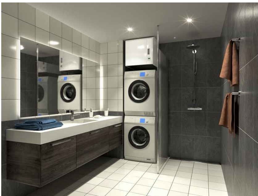
KUVA 13. Ilmanvaihtokone sijoitettuna pyykitornin päälle (Enervent, 2008)
