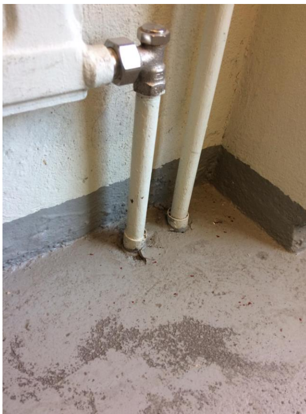
Kuva 21. Teräsputket oikeaoppisesti suojaputkeen asennettuna rakenteen sisään. Perttu Myllymäki. 2020
