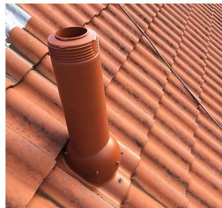
Kuva 12. Tuuletusviemäri vesikatolla eristettynä. Perttu Myllymäki. 2019.
