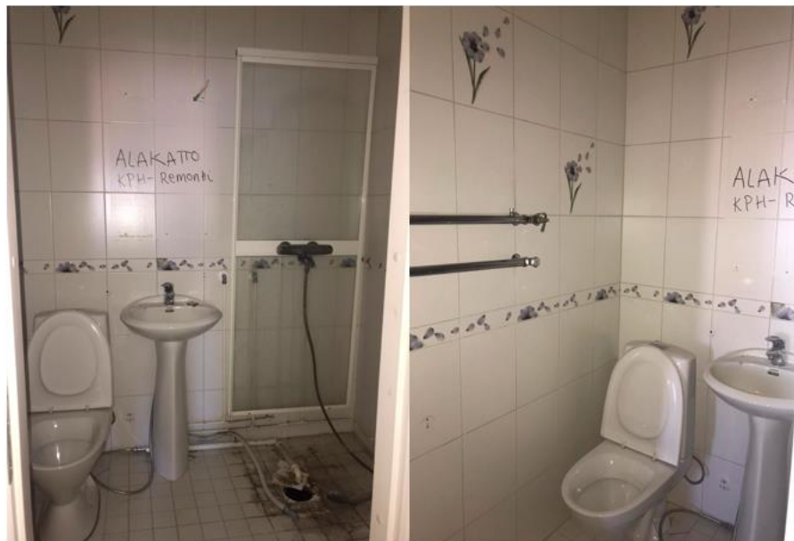
Kuva 11. Esimerkkikylpyhuone, alkuperäinen tilanne.
