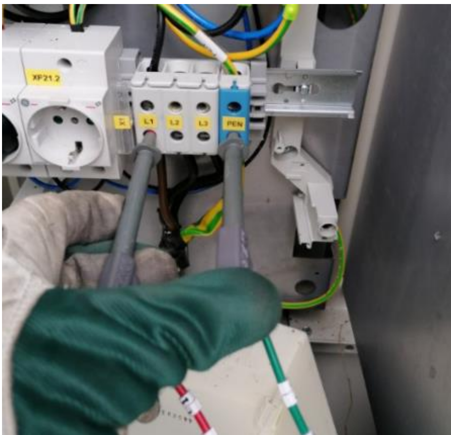
Kuva 13. Vaihejännitteen mittaaminen.
