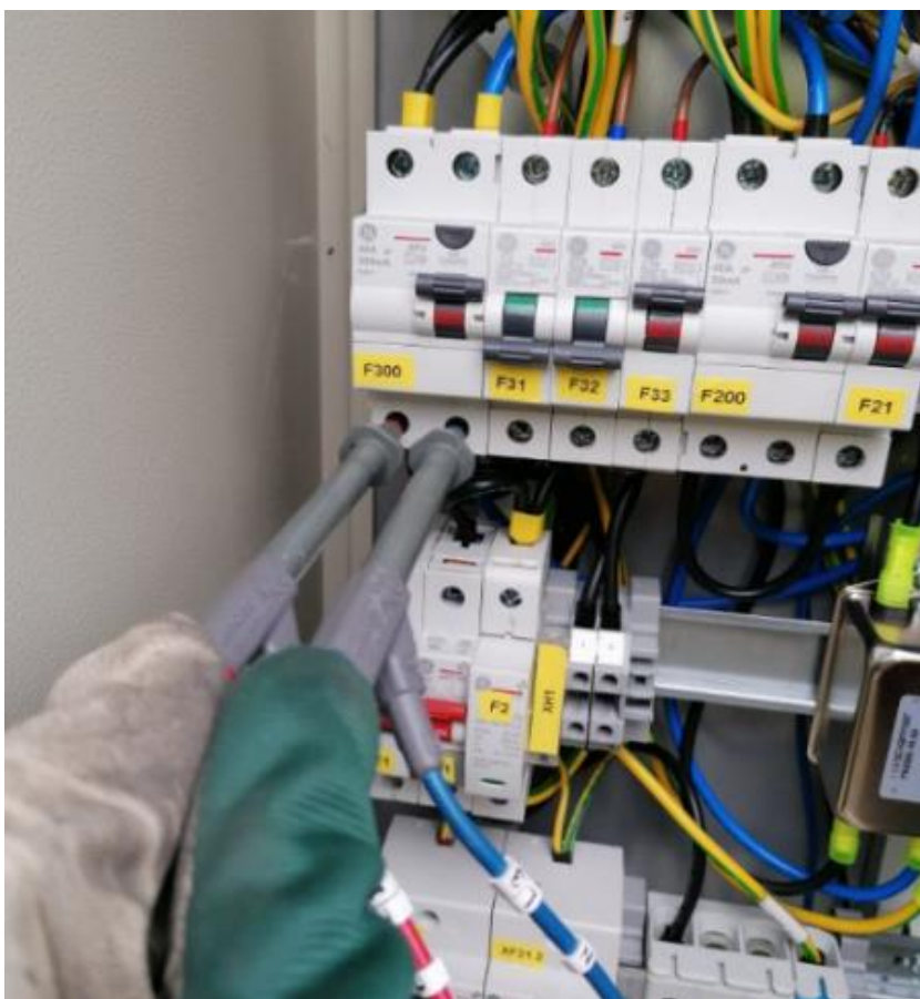
Kuva 12. Vikavirtasuojakytkimen toiminnan mittaus.
