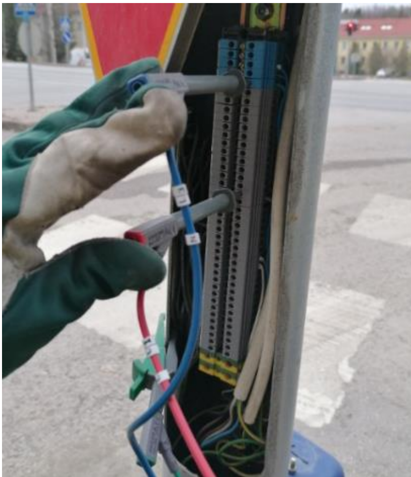
Kuva 11. Esimerkkikytkentä oikosulkuvirtaa mitatessa.
