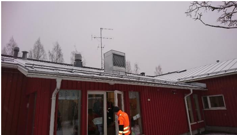
Kuva 18. Ulkoilmasäleikön sijoittelu poikkesi esitiedoista
