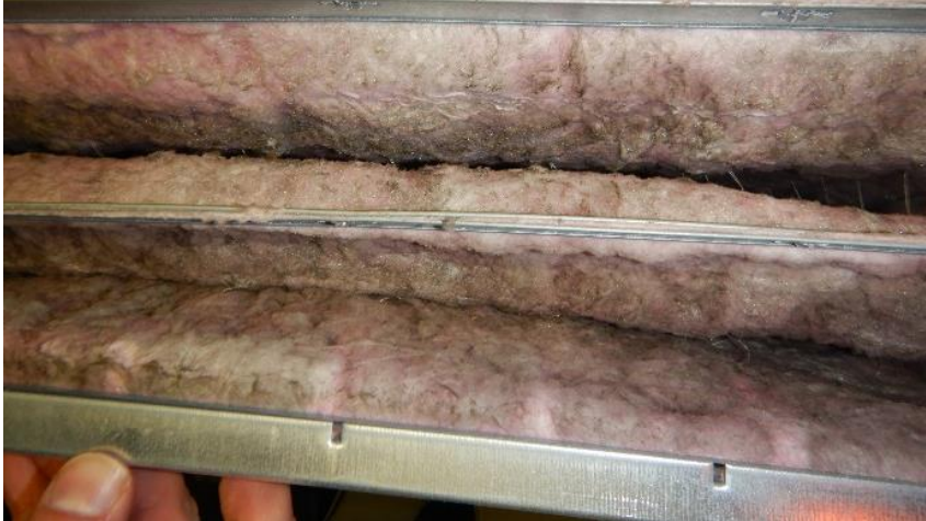
Kuva 19. Suodattimet olivat lumiset ja kastuneet
