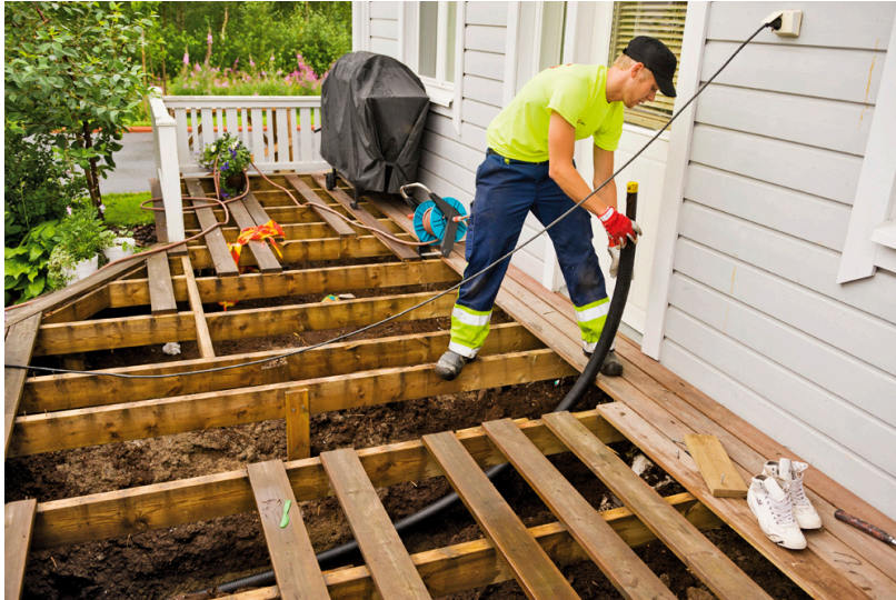
Kuva 5. Keräysletkun veto tekniseen tilaan [34].
