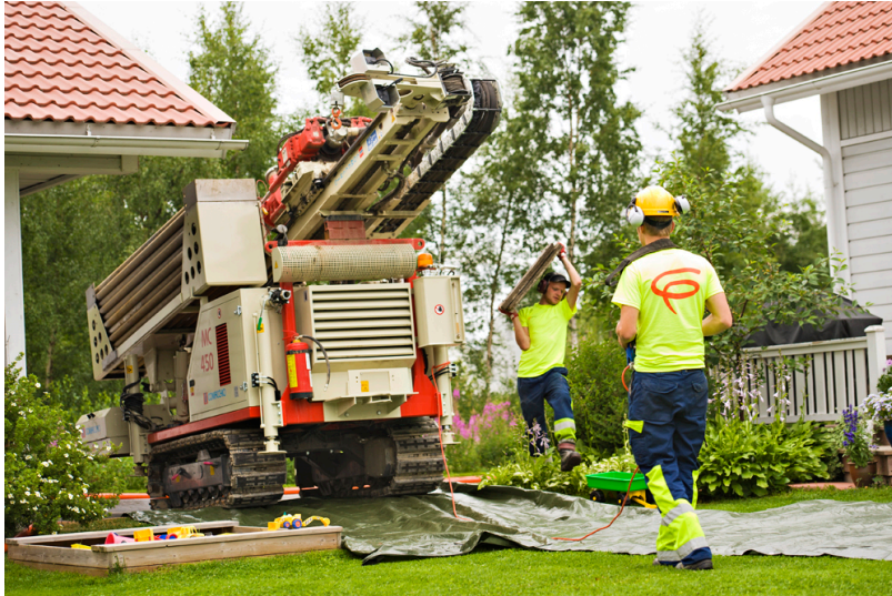
Kuva 3. Maalämpökaivon porauslaitteisto [34].
