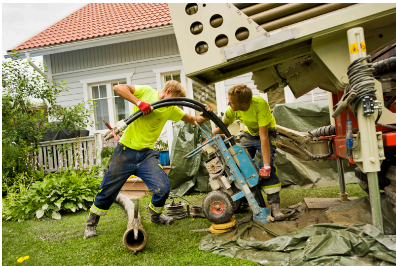
Kuva 4. Keräysletkun asennus [34].
