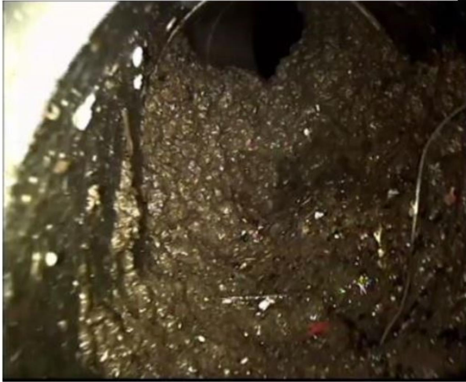
Kuva 13. Putki on lähes tukossa, vaikutus virtaamaan ilmeinen [8]
