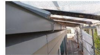
18.7.2018 pihan puolen uuden räystäskourun asennus aloitettu
