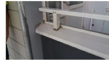
11.7.2018 Urakoitsija viimeistelee parvekkeiden pellitykset ennen telinepurkua
