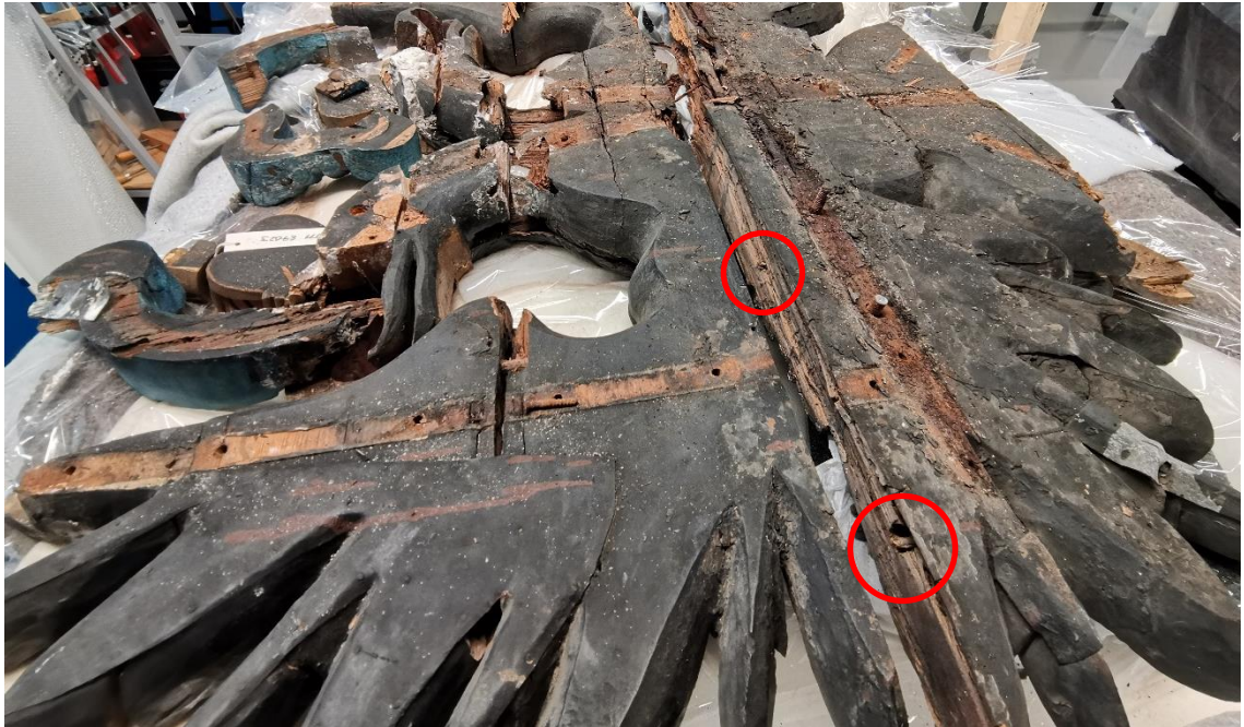
Kuva 4. Rakenteen vanhoja tappiliitoksia näkyvissä.
