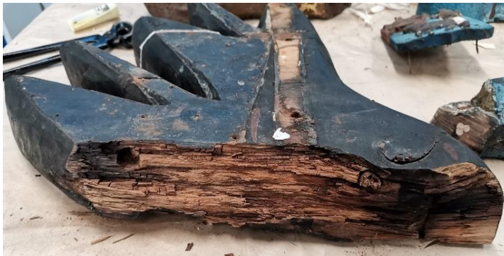
Kuva 23. Lahovauriota siiven alaosassa.
