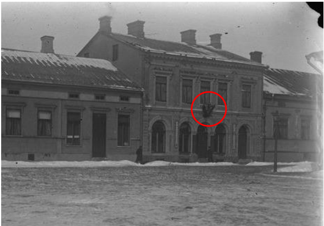
Kuva 3. Venäjän vaakuna rakennuksen julkisivussa Antinkatu 11, Pori. (Kuvaaja tuntematon, 1900-luvun alku)
