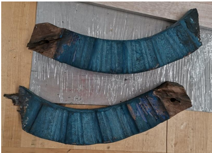
Kuva 15. Lahovaurioita kruunun ja nauhojen liitoskohdassa.
