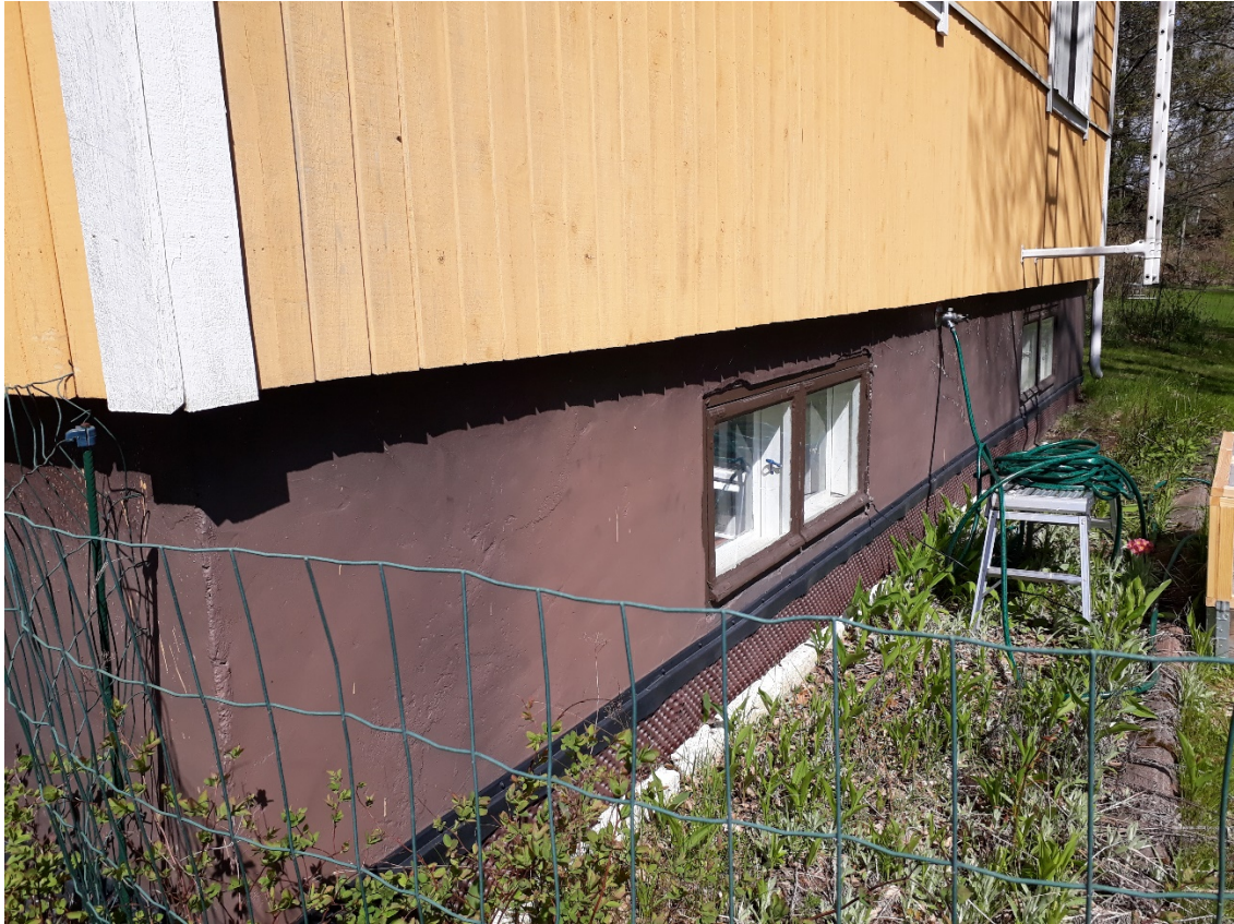
KUVA 17. Perusmuurilevy (patolevy) ja rapattu sokkeli. Kuvaaja: Halla Savisaari
