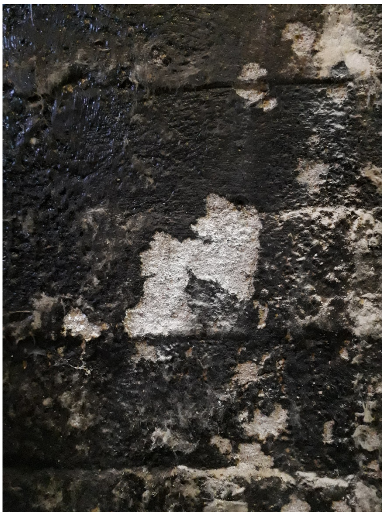
KUVA 19. Bitumisivelyä kellarinseinää. Kuvaaja: Halla Savisaari
