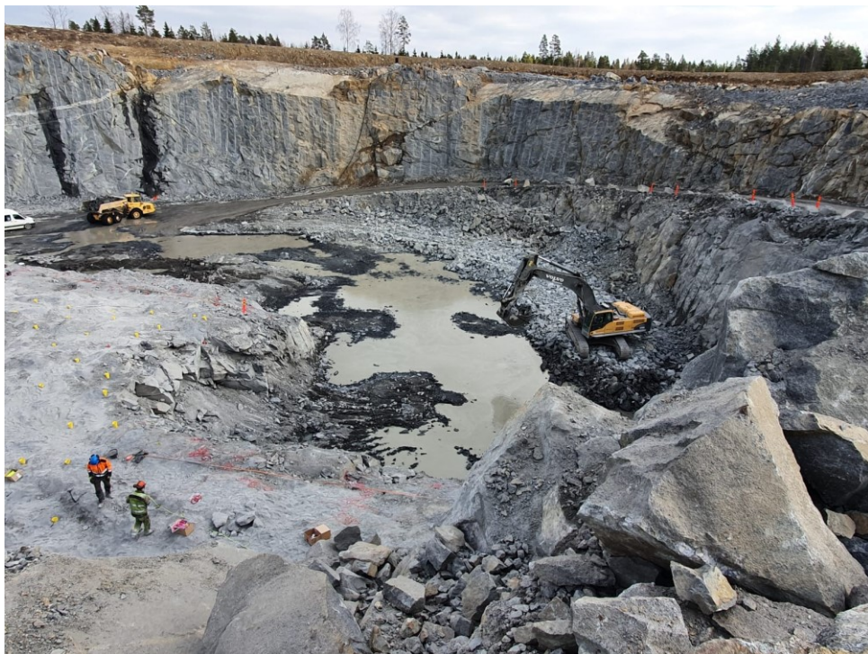
Kuva 1. Valkeakosken avokaivos, kuvassa näkyy kuinka ajorampit alkavat muodostua
