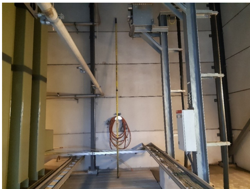
Kuva 13. Eristesauva ja työmaadoitusjohdot.
