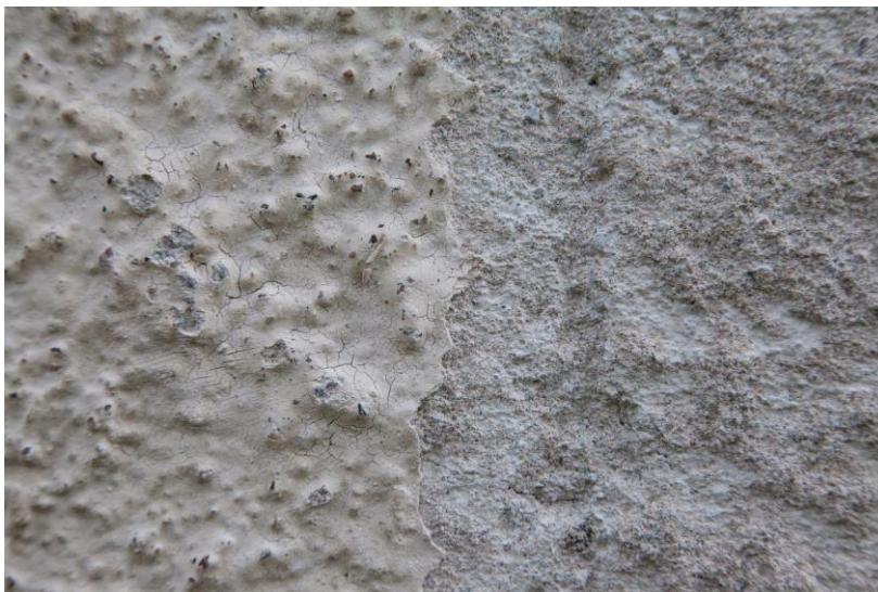
KUVA 10. Roiskerappauksen ja irrotetun seinämaalauksen raja keskellä.
