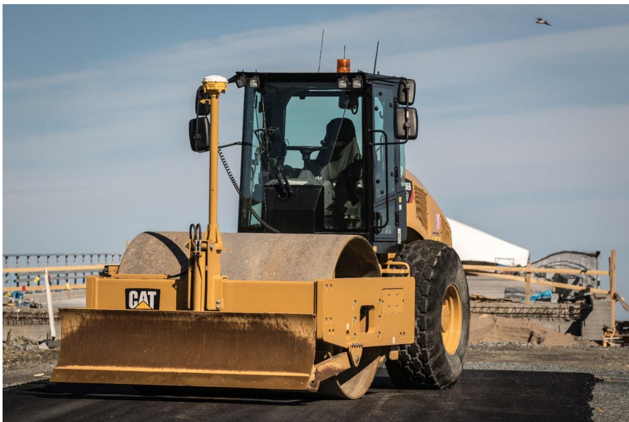
KUVA 4 Valssijyrä Trimblen koneohjausjärjestelmällä varustettuna (Pohjonen 2018-08)
