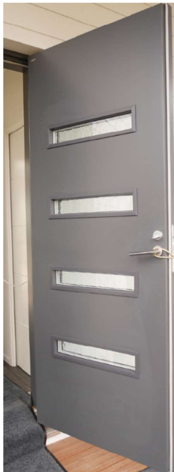
Kuva 9. Asunnon ovissa käytetään usein pieniä lasituksia (alle 250 mm), joiden ei tarvitse olla turvalasia.
