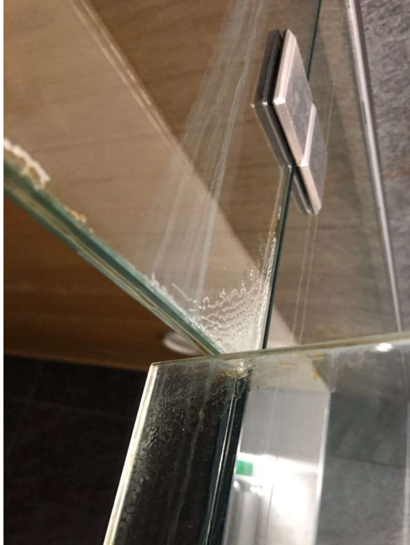
Kuva 26. Delaminoitunut lasi.
