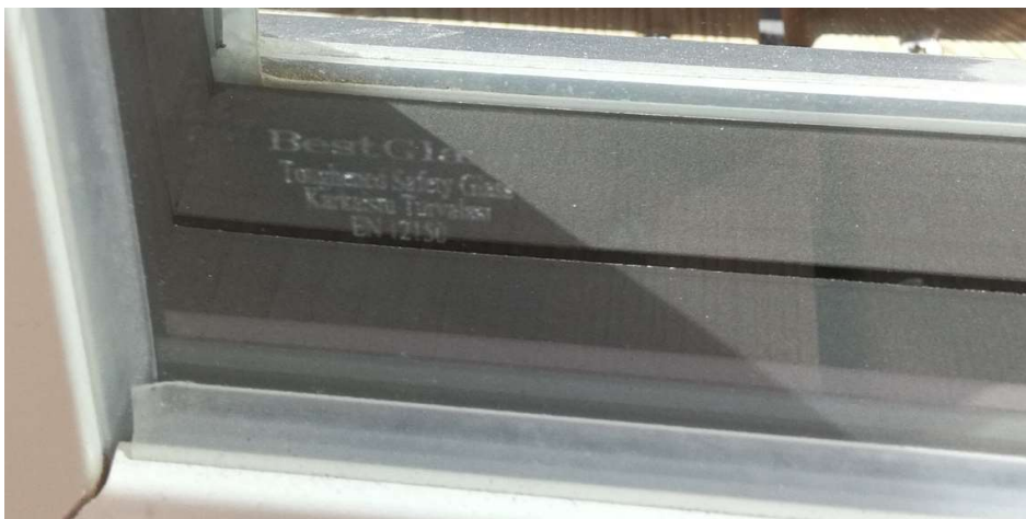
Kuva 32. Esimerkki karkaistun turvalasin merkinnästä.
