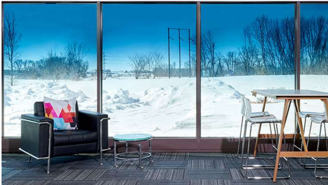
Kuva 23. Sähkökromaattinen lasi voidaan tummentaa esimerkiksi vain yläosastaan (Sageglass).
