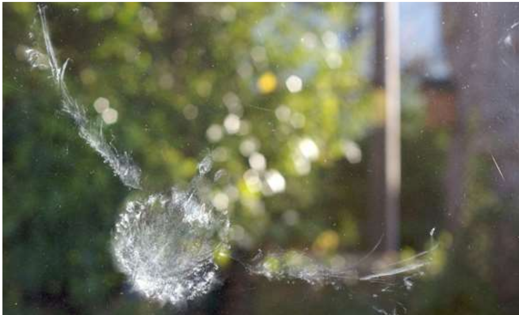
Kuva 30. Linnun törmäyksestä jäänyt jälki lasissa. (Huston 2012).
