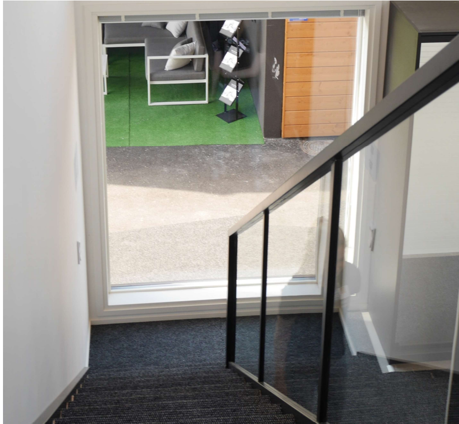
Kuva 7. Porrassyöksyssä on käytettävä turvalasia, kun lasituksen korkeus tasosta on vähemmän kuin 1500 mm. Asuntojen kohdalla ei ole lievennystä.
