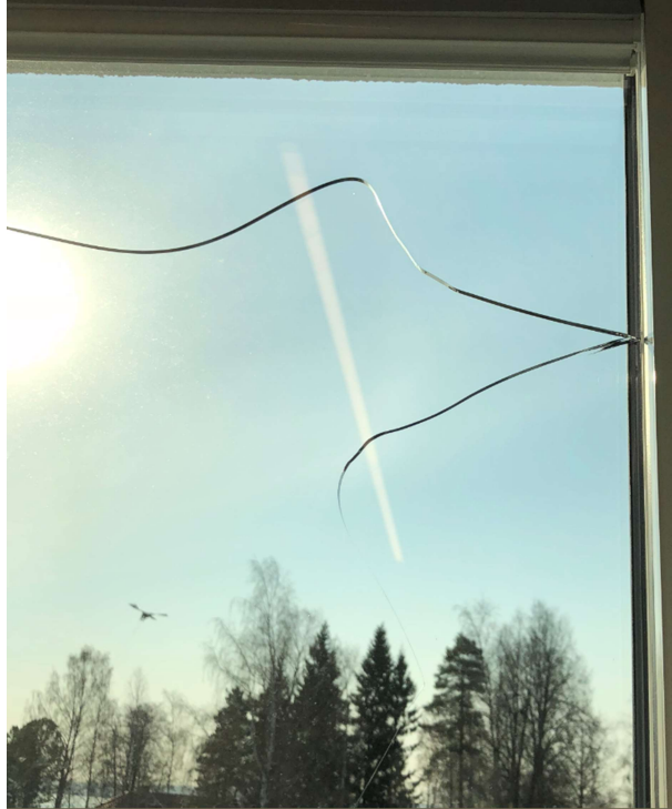
Kuva 28. Eristyslasin lämpörikko (Saukko 2020d).
