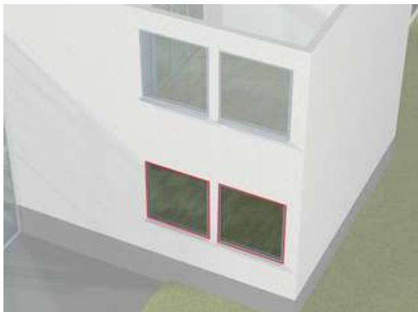
Kuva 5. Ikkunoissa ja lasiseinissä käytetään turvalasia, kun lasituksen alareunan korkeus lattiasta on alle 700 mm (Glascentrum 2016).
