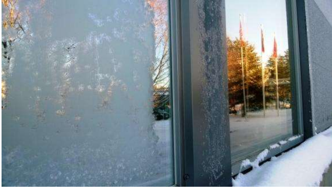
Kuva 25. Kuvassa huurtunut ikkuna Skaalan ikkunatehtaalla 25.11.2013 klo 11:45. Vasemmanpuoleinen energiatehokas eristyslaselementti on jäässä, kun oikeanpuoleinen vastaava elementti, mutta FrostFree-ominaisuudella, on pysynyt täysin kirkkaana. (Puuinfo 2013.)
