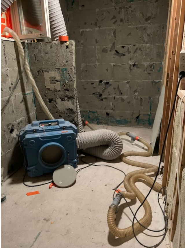
Kuva 4. Eristetilakuivaus.
