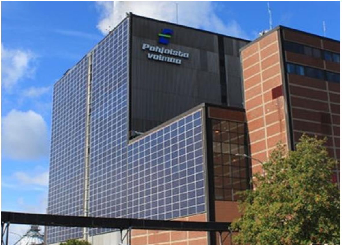
Kuva 10 Aurinkopaneelit osana rakennuksen julkisivua. (Kauppalehti, 2018)
