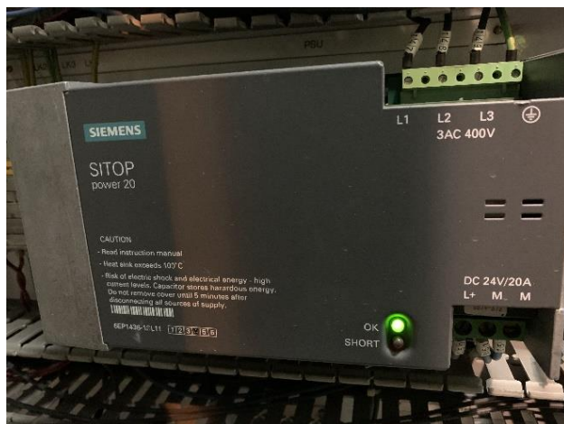
Kuva 30. Siemens SITOP Power 20 Tasajännitelähde. (Otra-aho, 2020)
