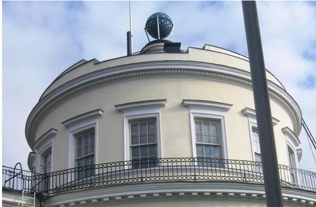
Kuva 4: Turun Vartiovuoren tähtitorni. Kuvassa katolla kuparinen pallo ja sen vieressä vasemmalla aikapallon ripustustanko. (MIP-rakennustietokanta.)
