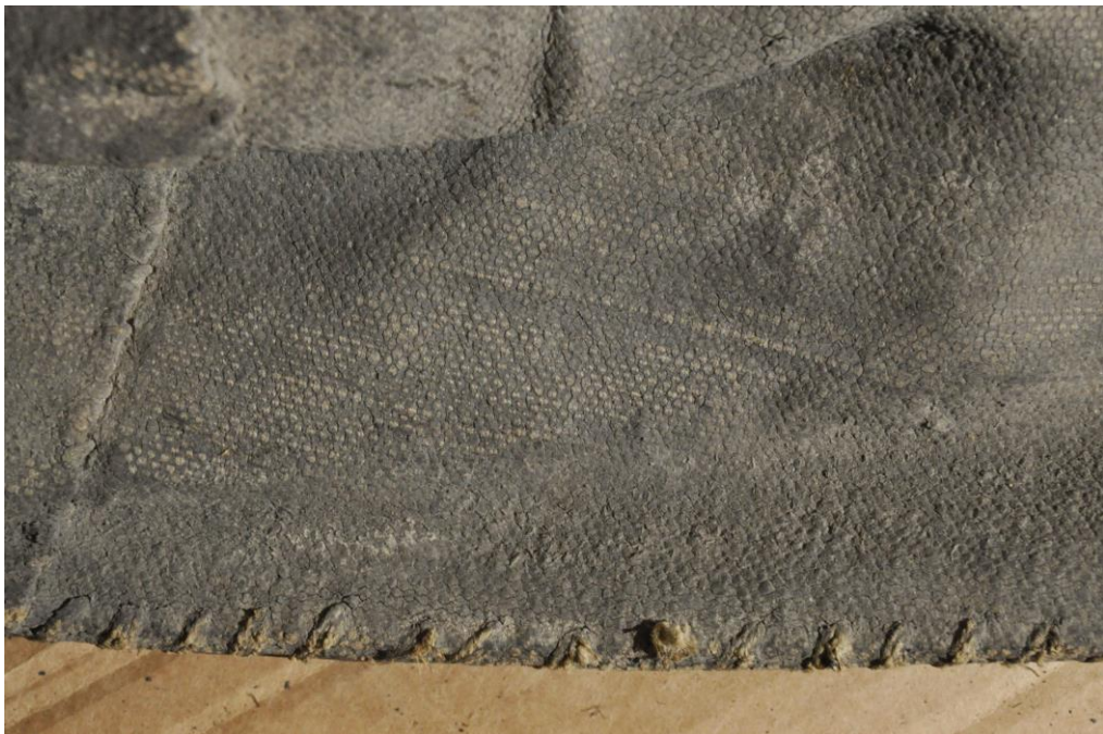
Kuva 50: Puhdistuskokeilun alue imuroinnin jälkeen.
