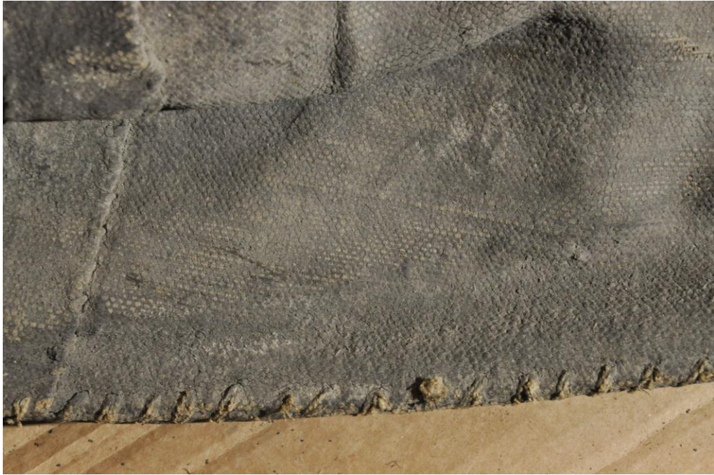
Kuva 49: Puhdistuskokeilun alue ennen testiä.
