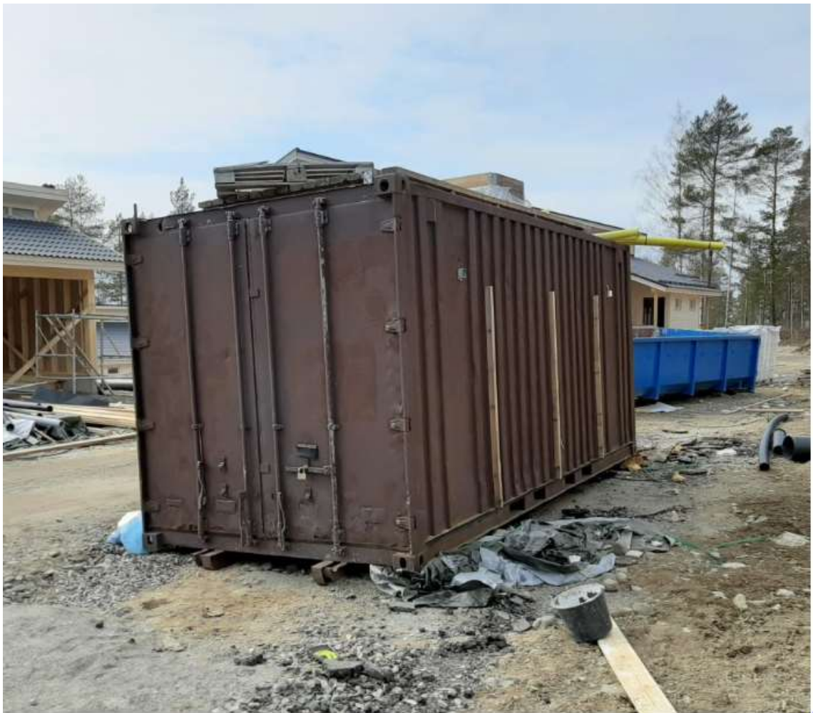
Kuva 7. Työmaavarastona käytettävä merikontti (Turunen 2020).
