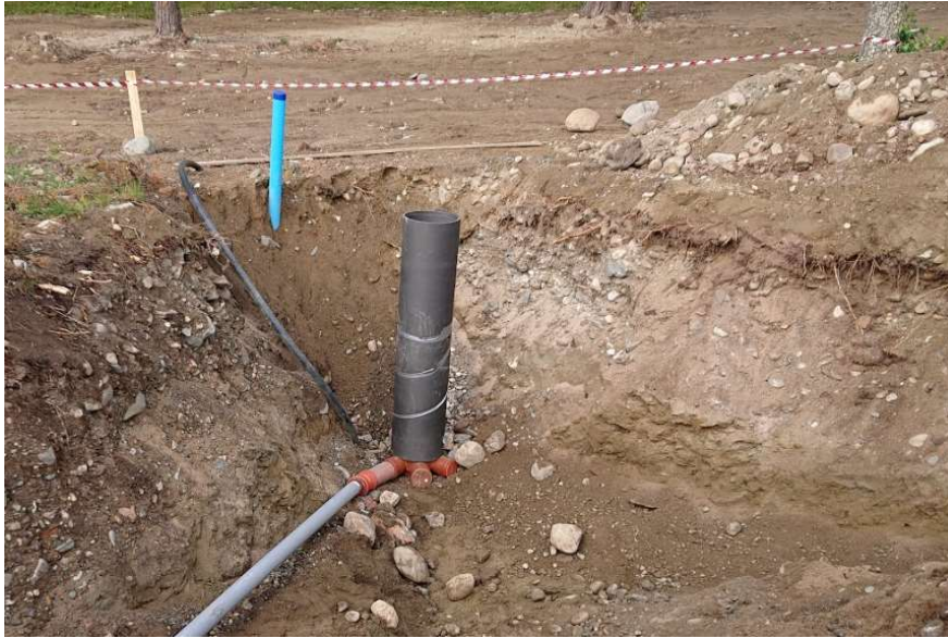
Kuva 3. Vesi- ja viemärintilinjien asennusta pohjatyövaiheessa (Turunen 2020).
