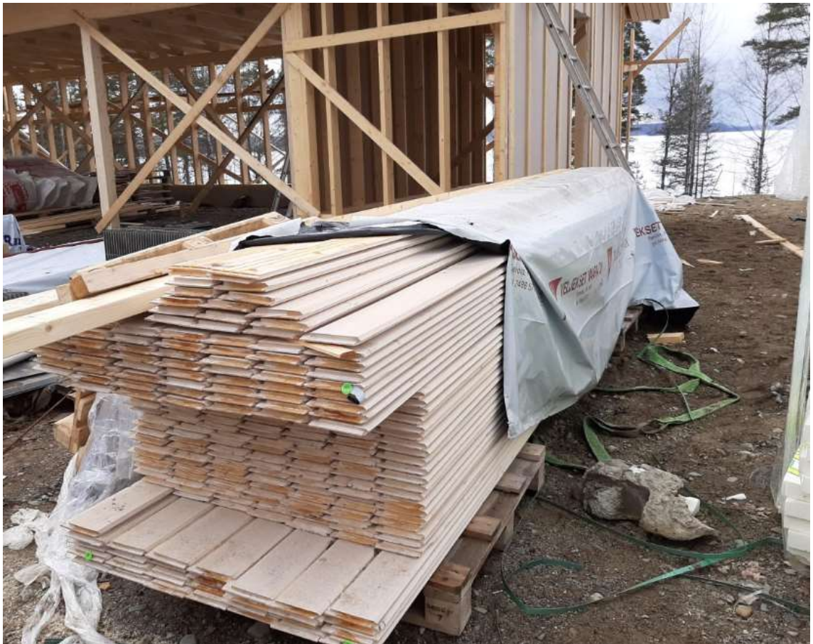
Kuva 8. Ulkoverhouspaneelit ulkovarastoinnissa (Turunen 2020).
