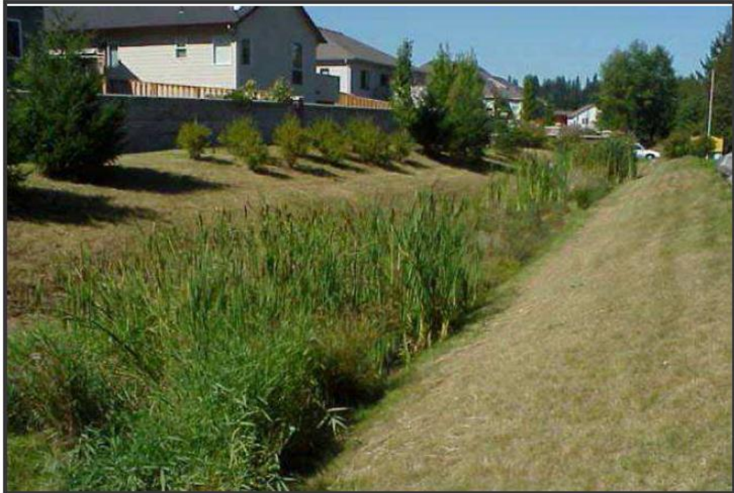
Kuva 15. Hulevesiä viivytävä leveä viherpainanne /13/.
