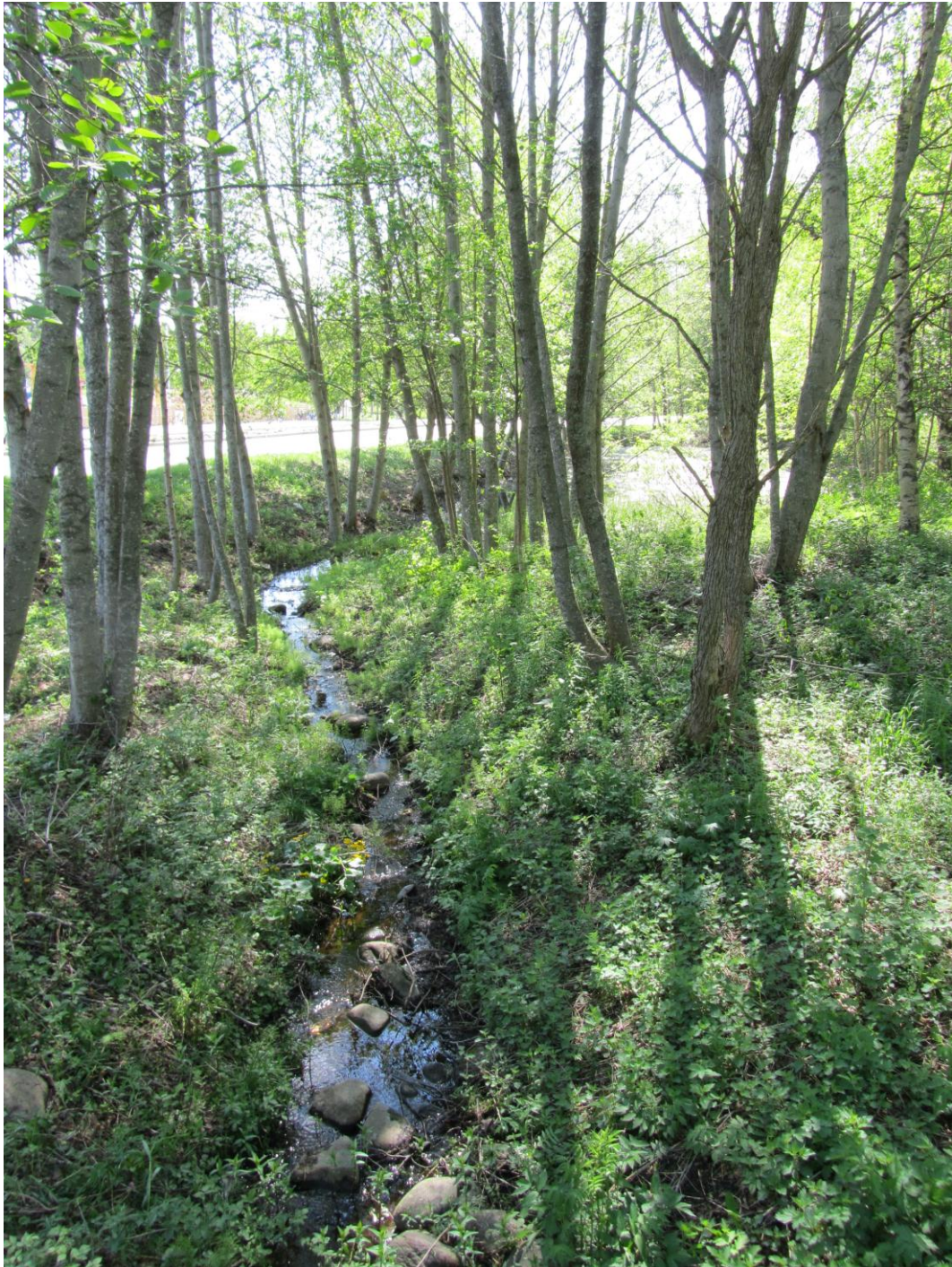
Kuva 23. Ylivuotopadosta vedet ohjautuvat puroa pitkin kohti ketjun seuraavaa lammikkoa. Kuva kesältä 2011 (Olli Litmanen).
