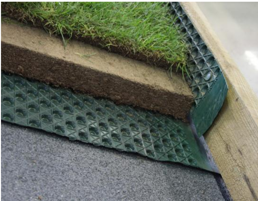
Kuva 7. Esimerkki viherkaton rakenteesta
