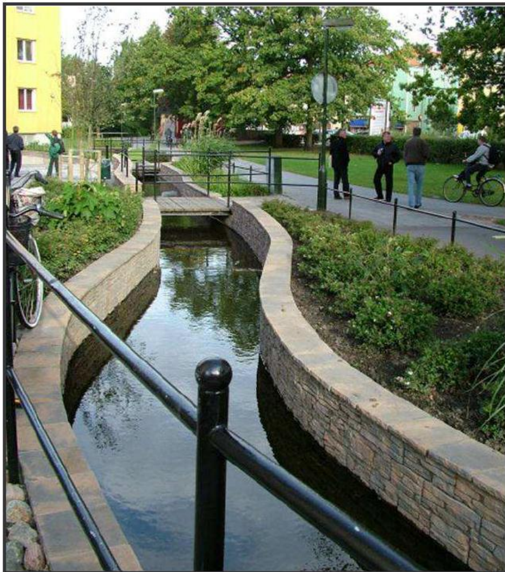
Kuva 16. Rakennettu kanava suurille vesimäärille /13/.
