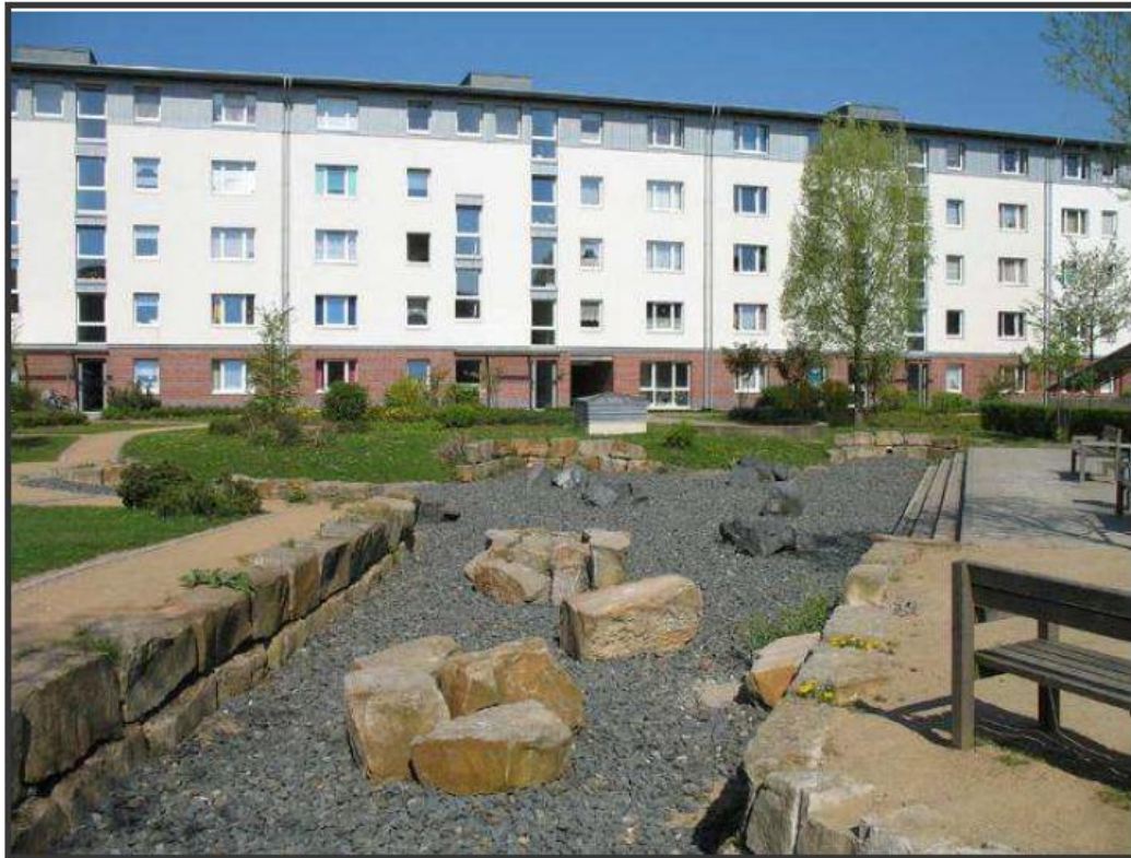
Kuva 12. Karkealla kiviaineksella täytetty viivytysoja asuinalueella /13/.
