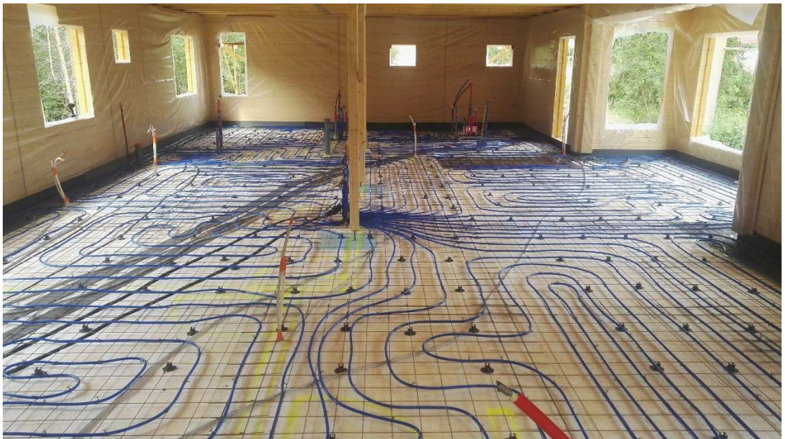
Kuvio 5. Vesikiertoinen lattialämmitys järjestelmä.
