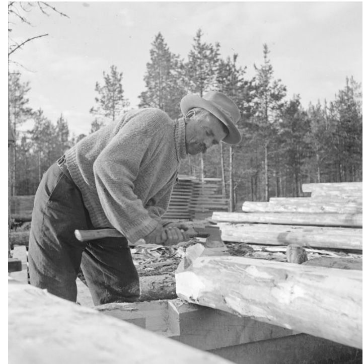
Kuva 4. Muoniolainen isäntä hirsä salvaamassa. (Pietinen, Otso, k. 1938.)
