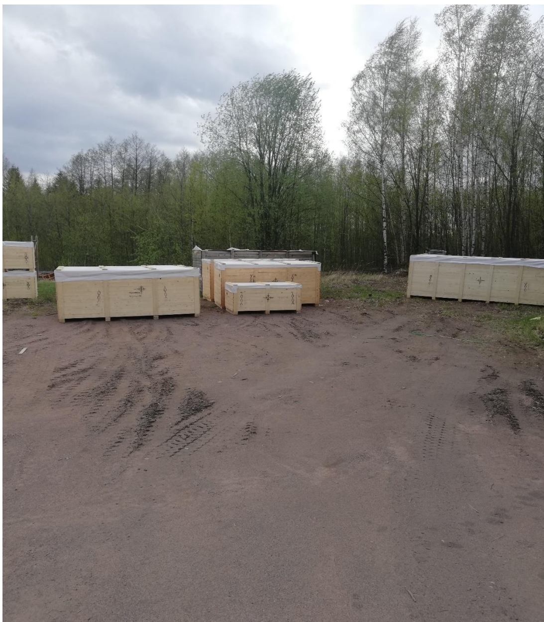
Kuva 7. Merilaatikkopakkausten säilytysalue ei ole katettu eikä päällystetty.
