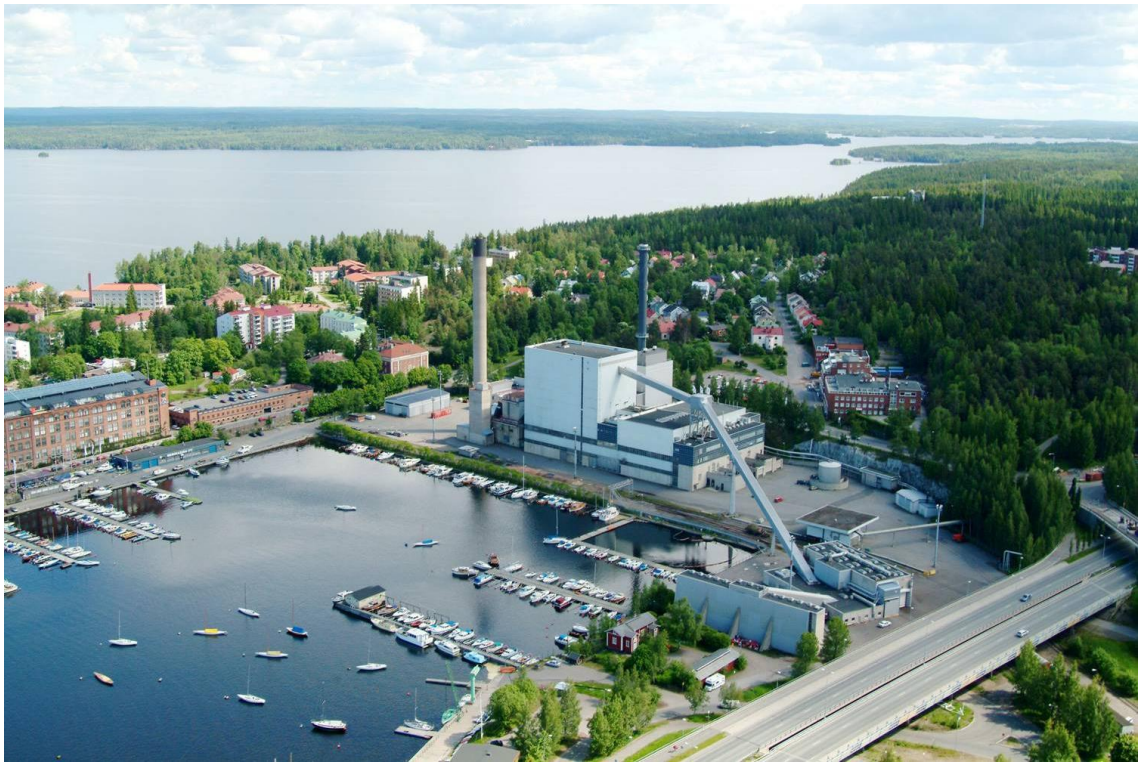
KUVA 1. Naistenlahden voimalaitos ilmasta kuvattuna. (Kuva: Tampereen Energiantuotanto Oy:n arkisto)
