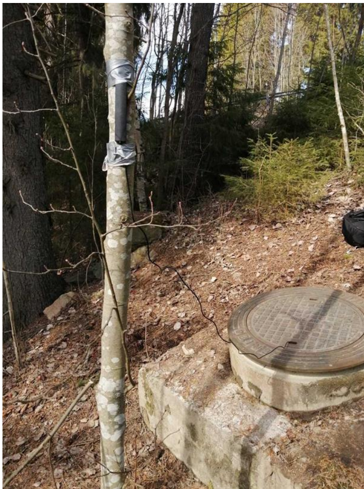
Kuva 5. Hulevesikaivo ja antenniratkaisu testissä 3. (Pajula, Pasi 2020)
