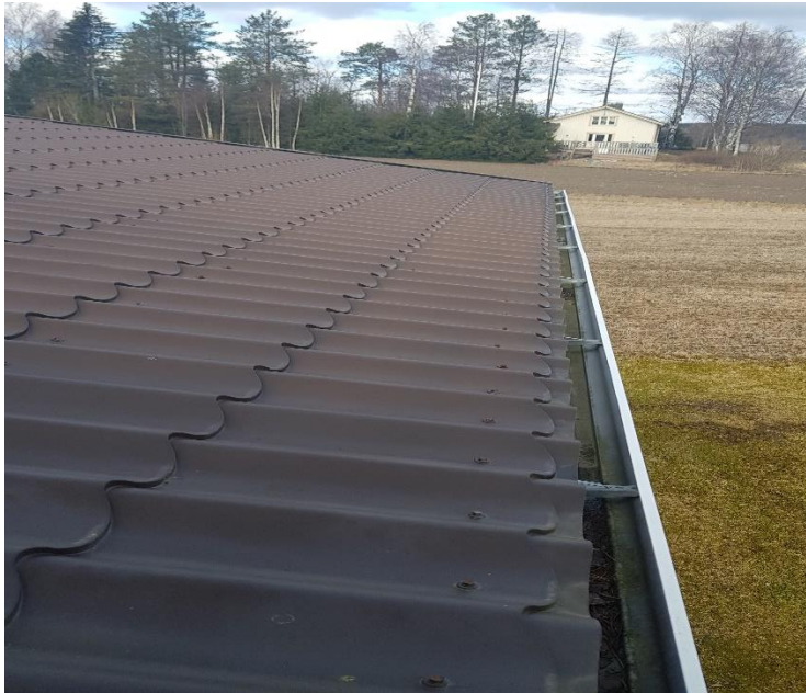
Kuva 9. Katto ja räystääs.
