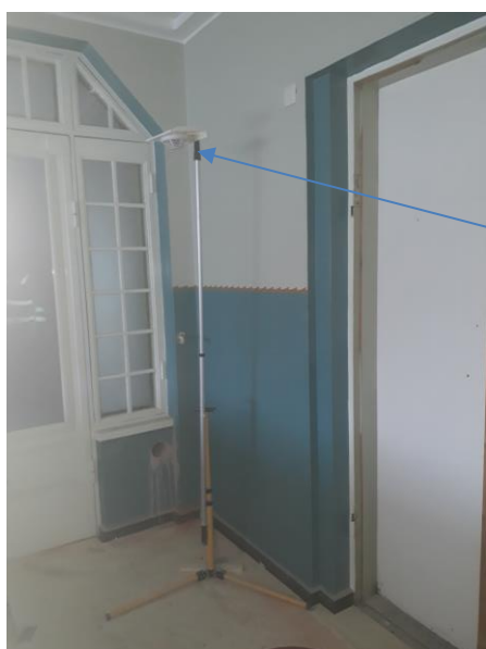
Kuva 25. Työmaan palovaroitinjärjestelmä. Kuva: Pekka Ronkainen.
