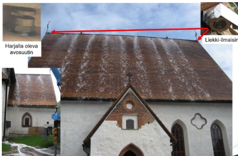
Kuva 17. Vesivalelu lauenneena. Liekki-ilmaisin havaitsee liekin, ja antaa laukaisukäskyn vesivalelujärjestelmään. Kuva: IUPL arkisto /23/
