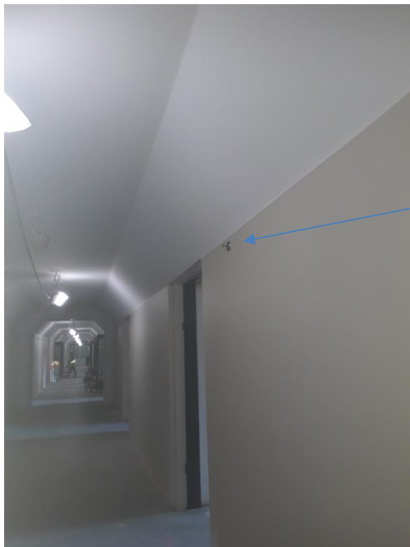
Kuva 9. Sprinklerisuuttimen seinäasennus. Kuva: Pekka Ronkainen
