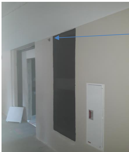
Kuva 4. Sprinklerisuuttimen seinäasennus. Kuva: Pekka Ronkainen
