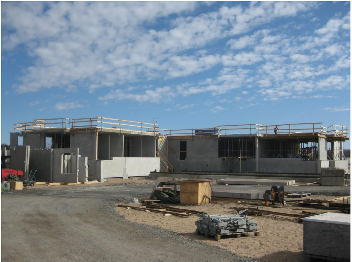
Kuva 12. Talon 2 1. kerroksen holvivalu
