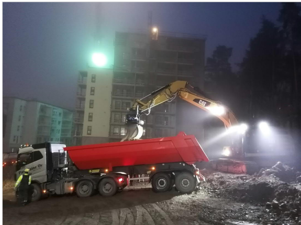
Kuva 4. Tela-alustainen kaivinkone lastaamassa puoliperävaunulla varustettua kuorma-autoa (kuva: Salmela, 2019).
