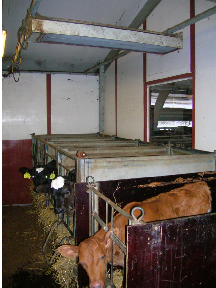
KUVA 6 Mahdollinen tulipalon lähde on vasikoita lämmittävä säteilylämmitin. (Mäkelä 2009)
