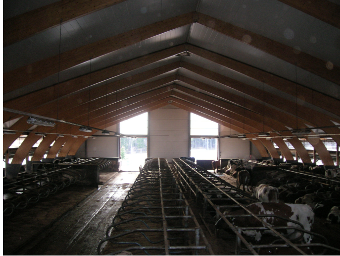
KUVA 12 Lehmien pelastamisreittinä ulos toimivat länsipäädyn kaksi, kolme metriä leveää liukuovea. (Mäkelä 2009)
