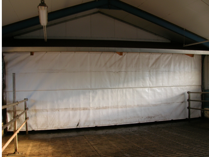
KUVA 5 Lypsyasemasiipi pystytään eristämään eläintilasta alas laskettavalla verhol- la. (Mäkelä 2008)
