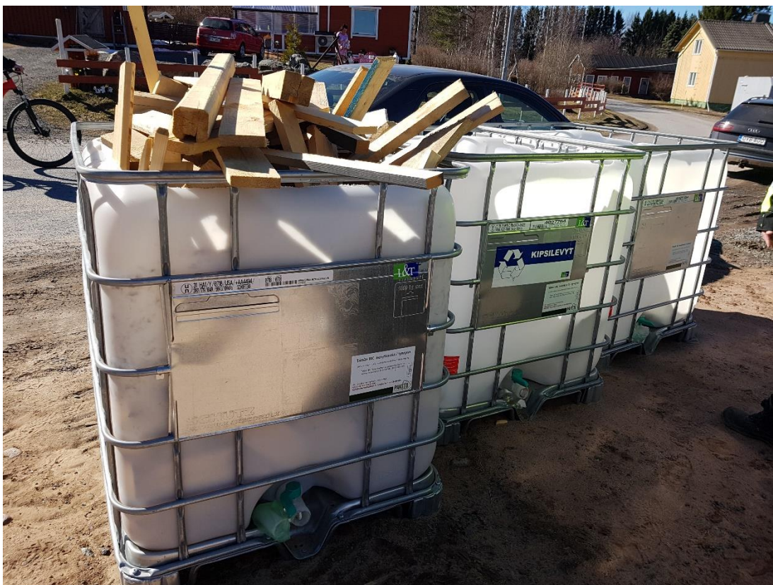
Kuva 15. Pilottikohteen puun, kipsilevyn sekä kiviäjätteen keräyspisteet.
