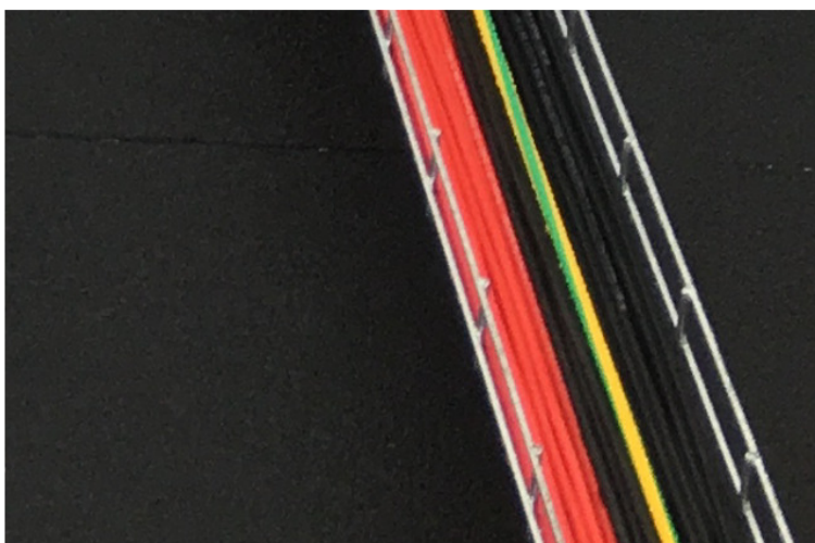
KUVA 20. Aurinkopaneelien tasajännitekaapeleiden asennustapa
