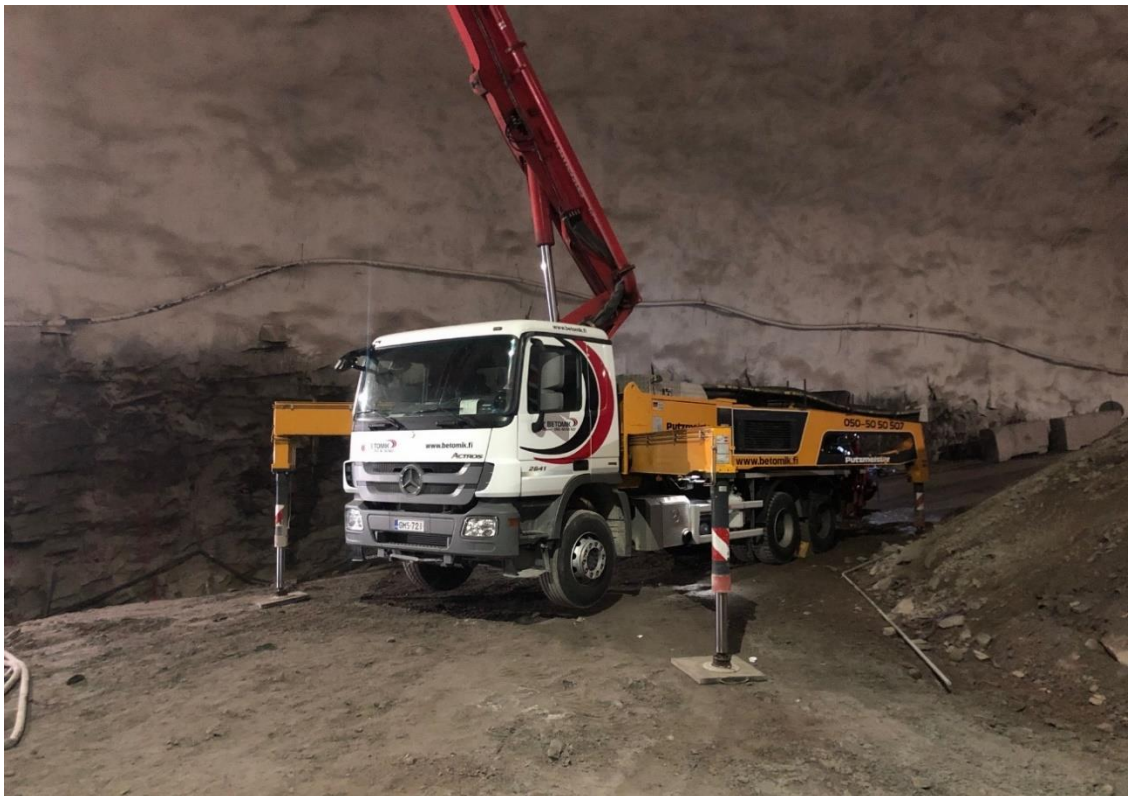
Kuva 3 Autobetonipumppu pystytettynä ja puomi avattuna sisätiloissa
