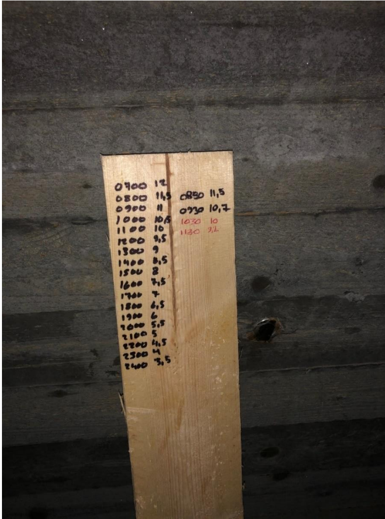
Kuva 4 Seinän nousunopeuden seuranta työmaalla. Vasemmalla puolella suunniteltu kellonaika ja jäljellä oleva valettava korkeus. Oikealla puolella toteutunut aika ja jäljellä oleva valukorko.
