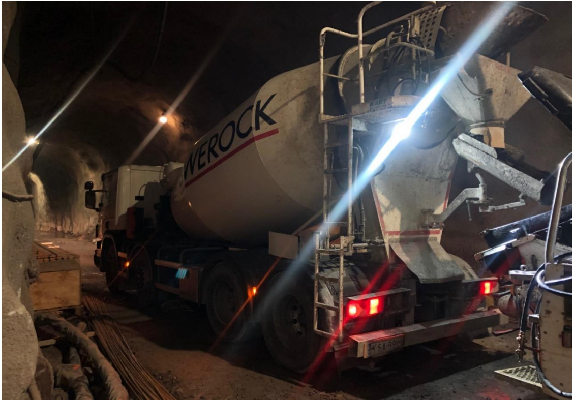
Kuva 2 Pyörintäsäiliösaauto purkamassa betonikuormaa
