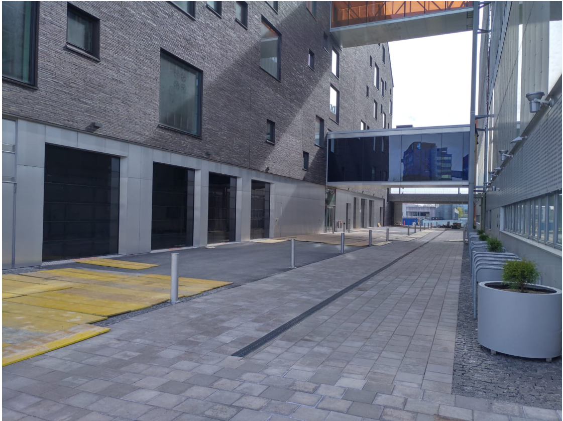
Kuva 2. Autolaboratorion neljä sisäänkäyntiä (vasemmalla).
