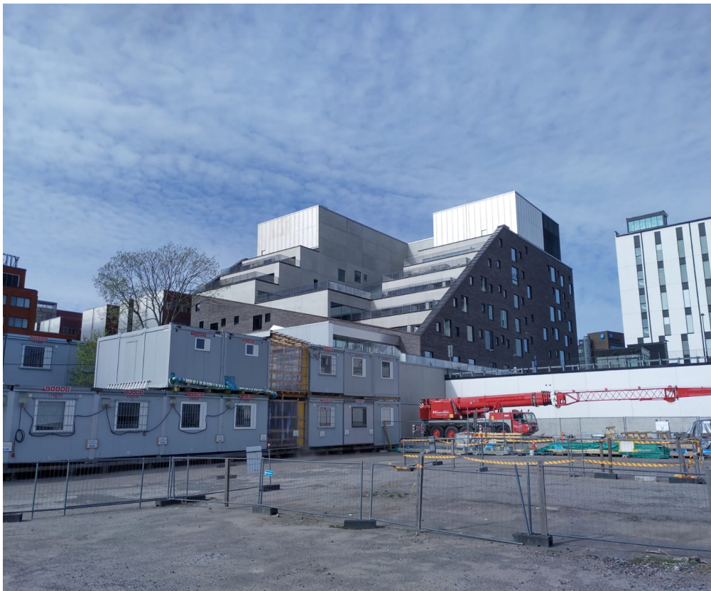
Kuva 1. EduCity, Kupittaaan kampuksen uudisrakennus toukokuussa 2020.
