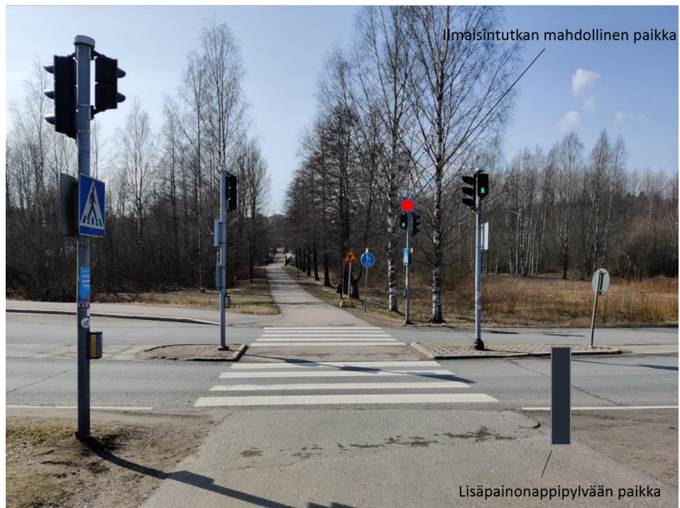
Kuva 9. Louhelantien ylittävä suojatie ja tutkan sekä lisäpainonappipylvään paikka.
