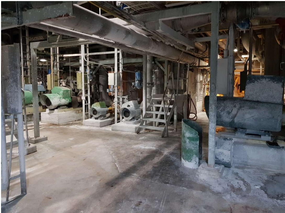
Kuva 11. Yleiskuva PK2 käytävältä, johon laitteisto on tarkoitus sijoittaa
