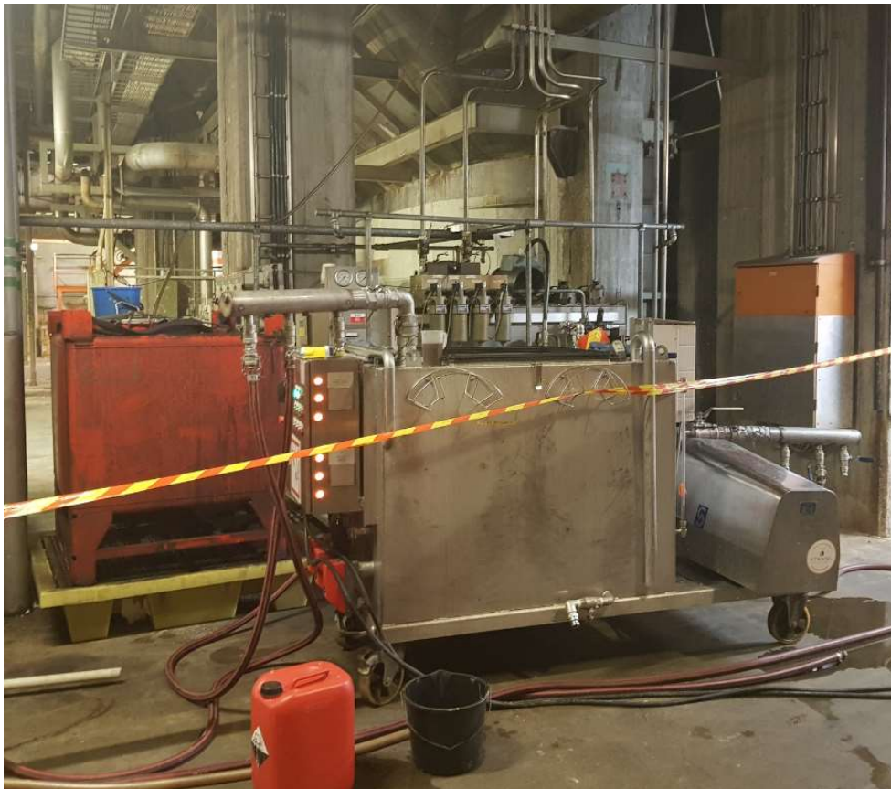
Kuva 10. Ulkopuolisen yrityksen pesuri puhdistamassa lämmönvaihtimia
