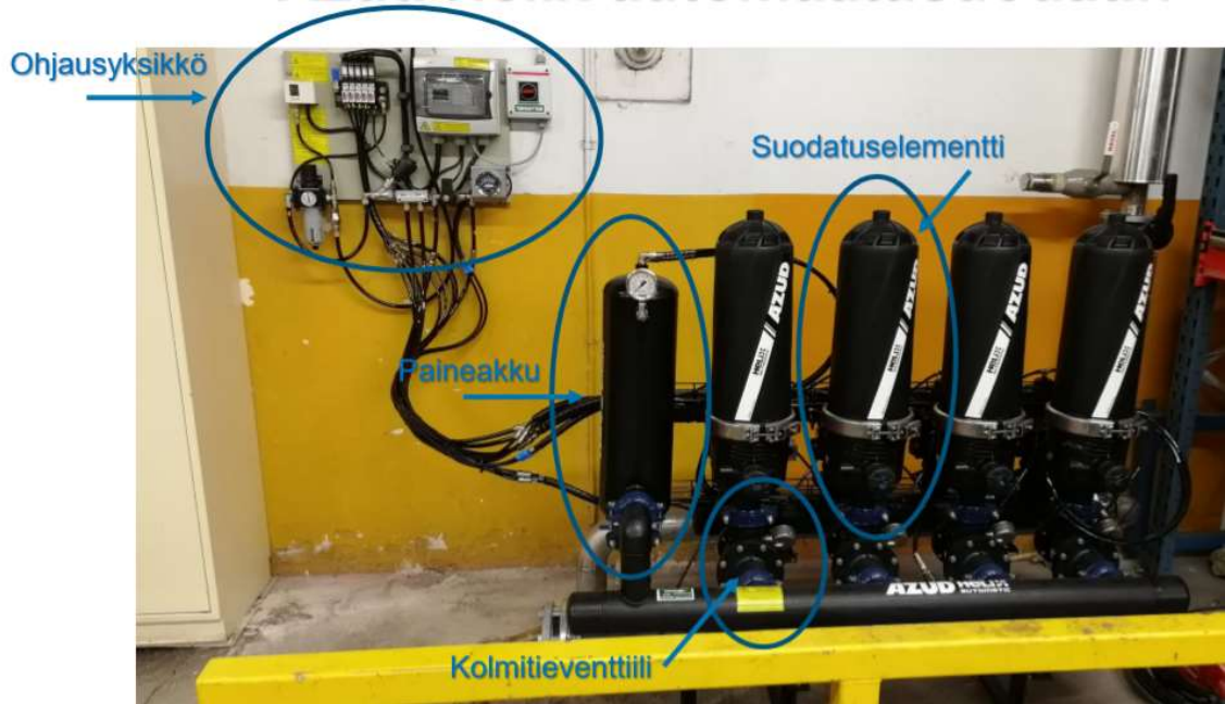
Kuva 27. AZUD-suodattimen osat (Hirvonen 2020a)
