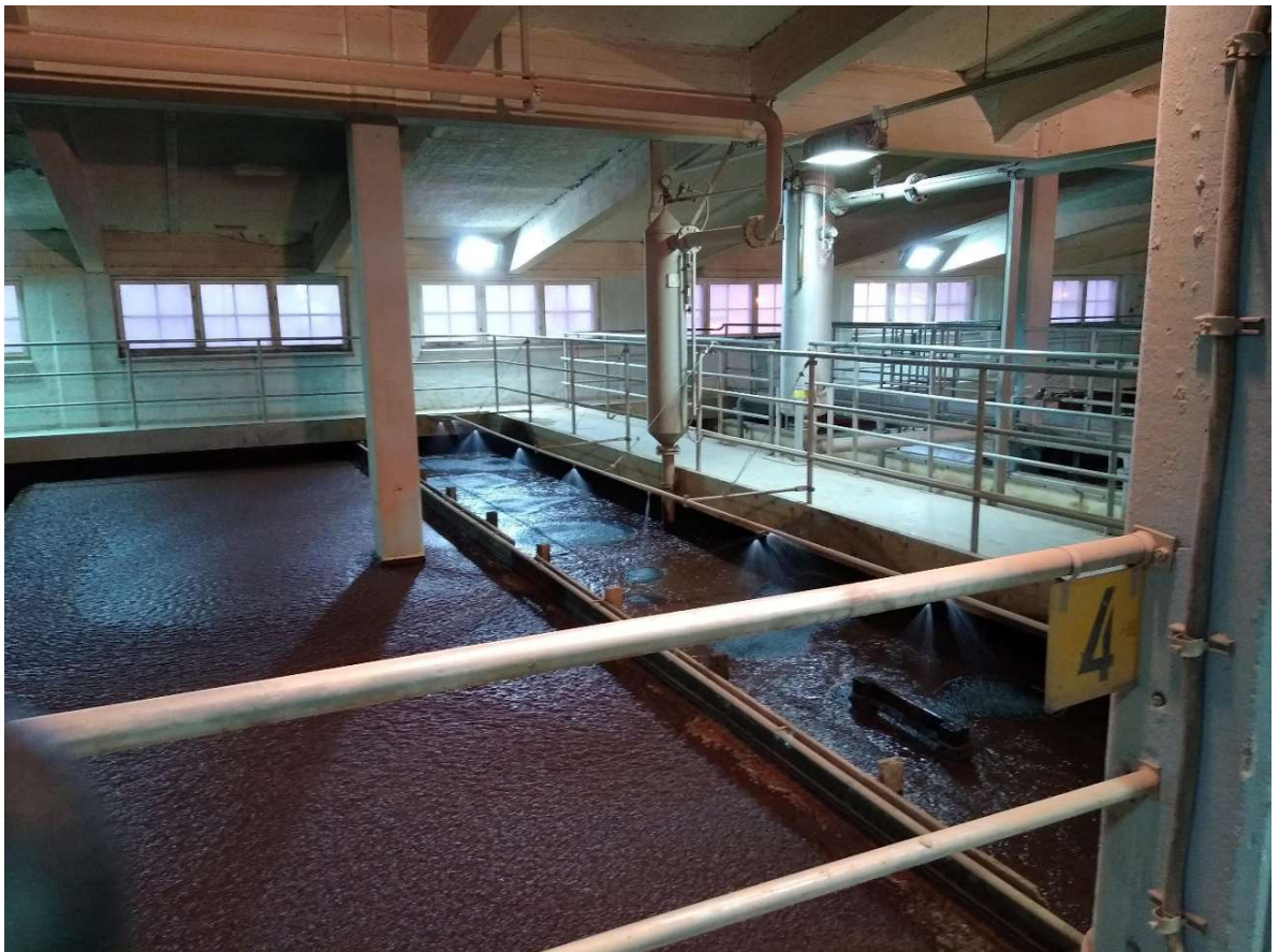
Kuva 3. Vesilaitoksen suodatusaltaat
