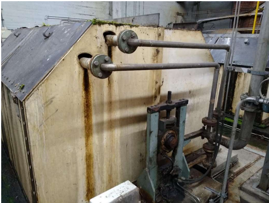
Kuva 6. Ketjukorisuotimelta lähtevät putkistolinjat
