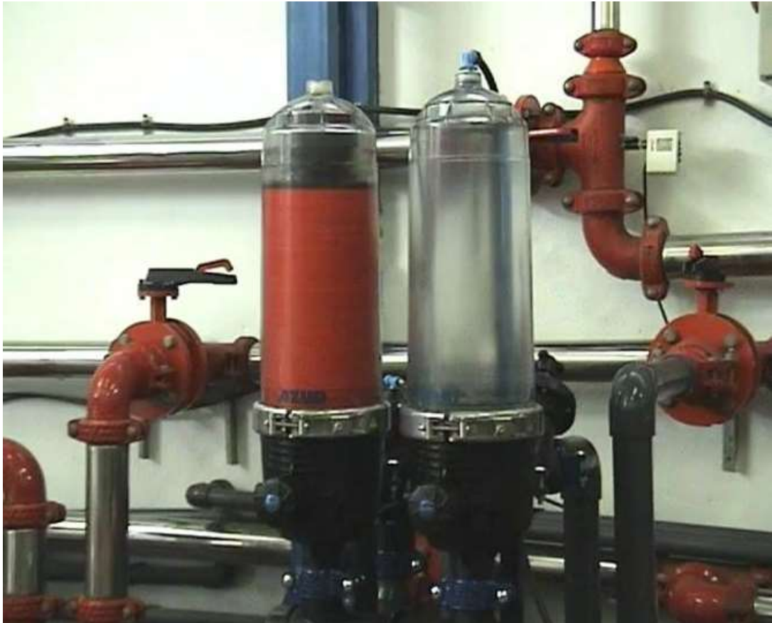
Kuva 32. AA-suodatin. Vasemmalla suodatinelementti ja oikealla paineakku (Hirvonen 2020a.)
