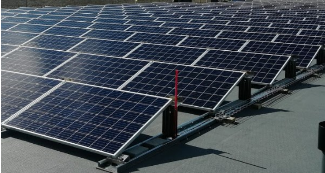
Kuvio 4 Aurinkopaneeleja 20 asteen kulmaan asennettuna PVC-katolla
