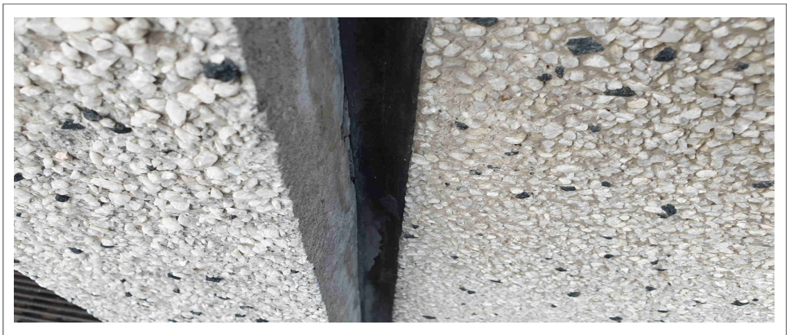
Kuva 3. Pesubetonipinta. Kuva: Arja Pekkala, 2020
