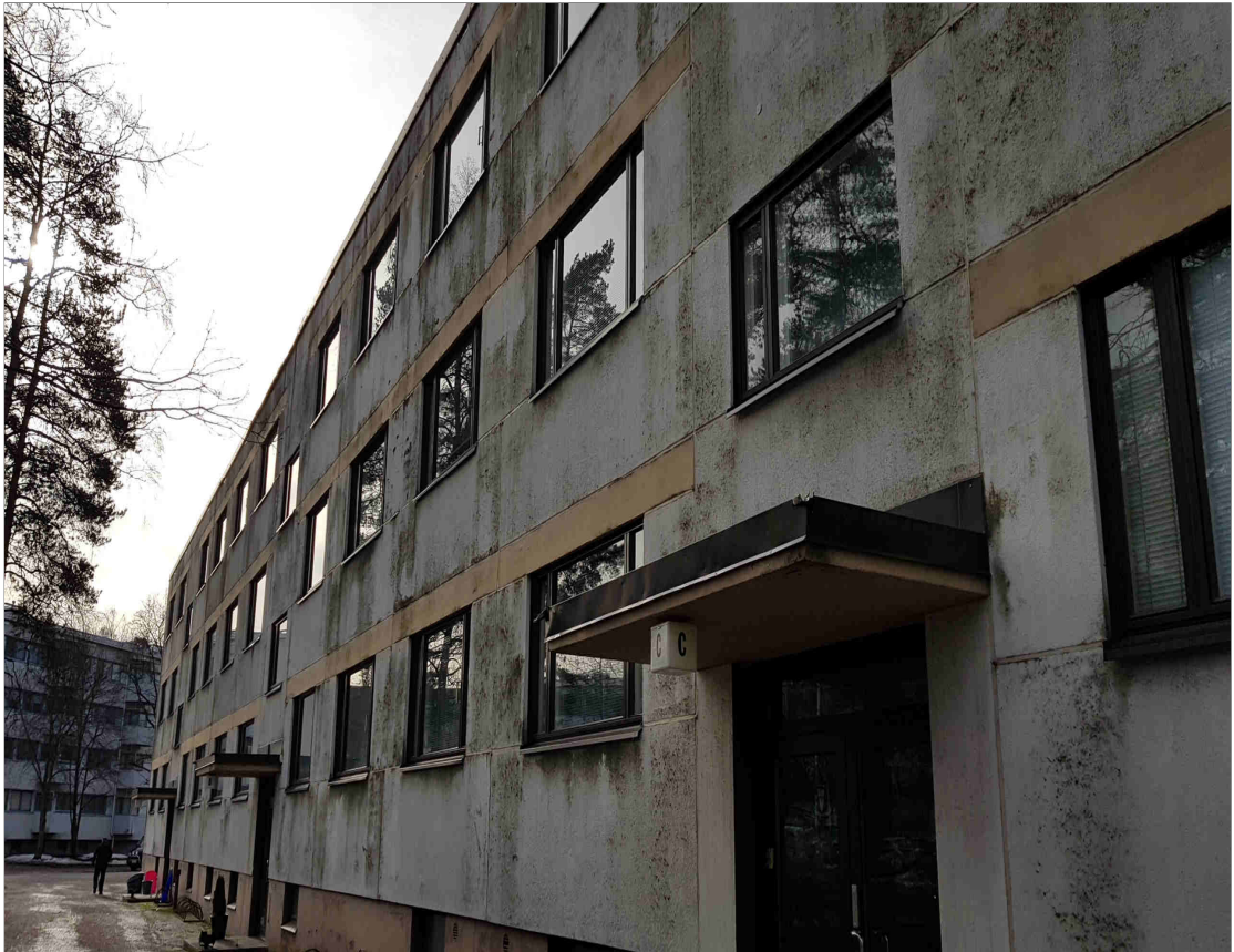
Kuva 15. Rakennuksen koillissivu oli voimakkaasti likaantunut, mutta pinnoitevaurioita ei havaittu. Kuva: Arja Pekkala 2019.
