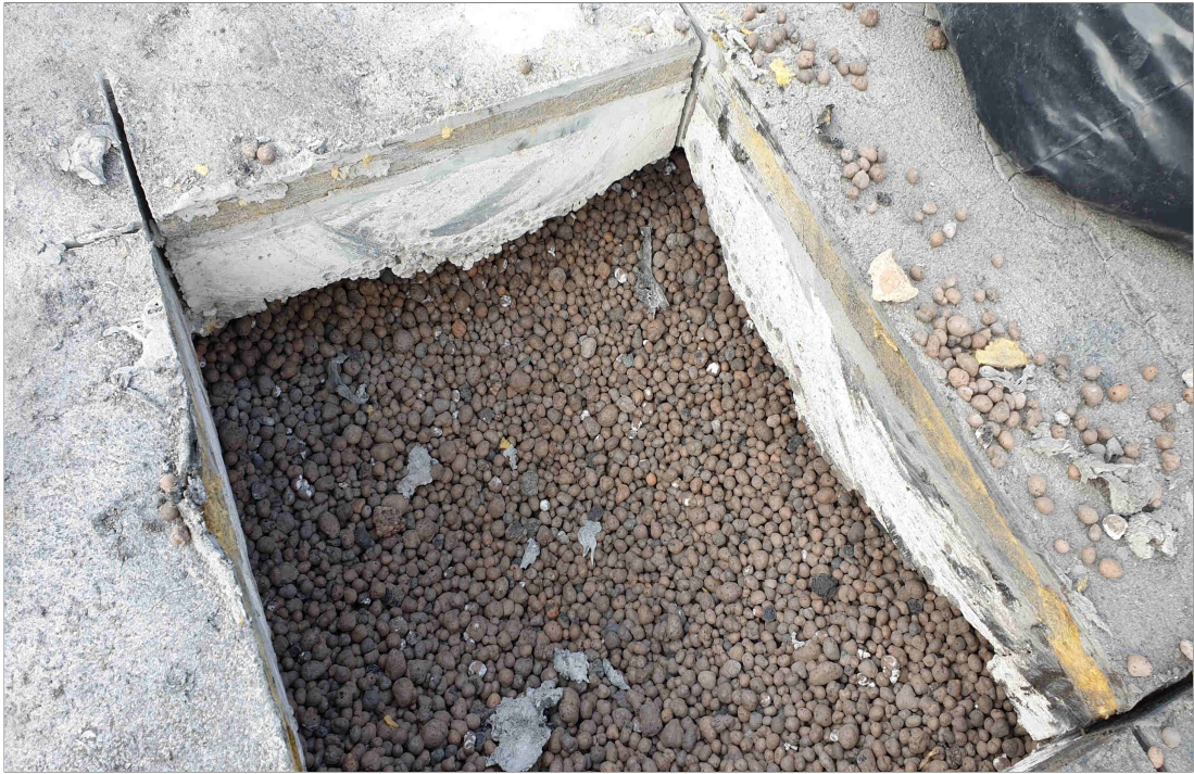
Kuva 22. Vesikaton rakenneavaus katon keskialueella. Kuva: Arja Pekkala 2019.
