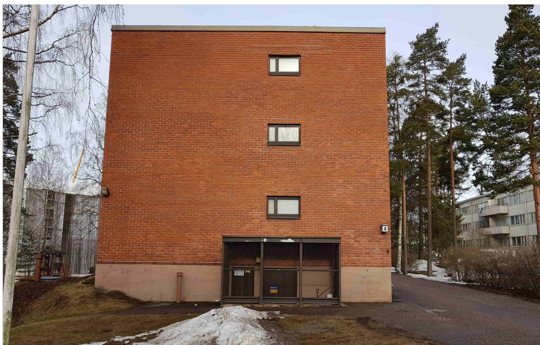
Kuva 18. Rakennuksen punatiilimuuratusta kaakkoispäädystä. Kuva: Arja Pekkala 2019.
