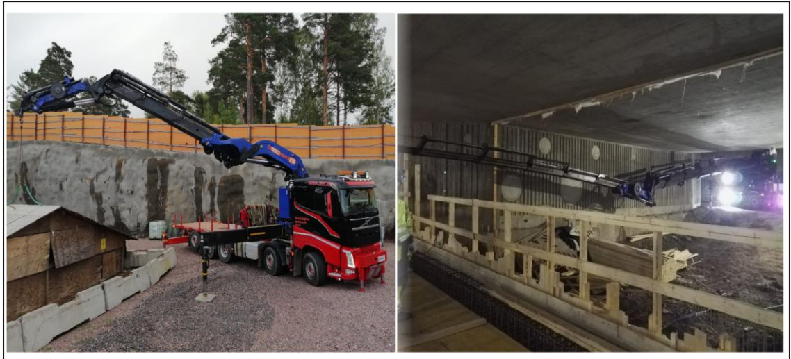
Kuva 13. Kuormausnosturi ja oikealla kuvattuna nostopuomin käyttöä ahtaassa tilassa
