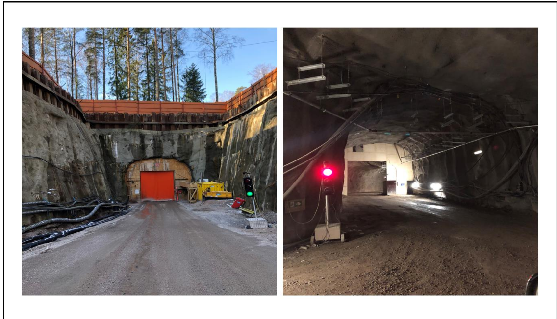
Kuva 7. Tunnelin suuaukolla työmaa-aikainen liikennevalo ohjaa työmaan ajoliikennettä huolto-tunneliin.
