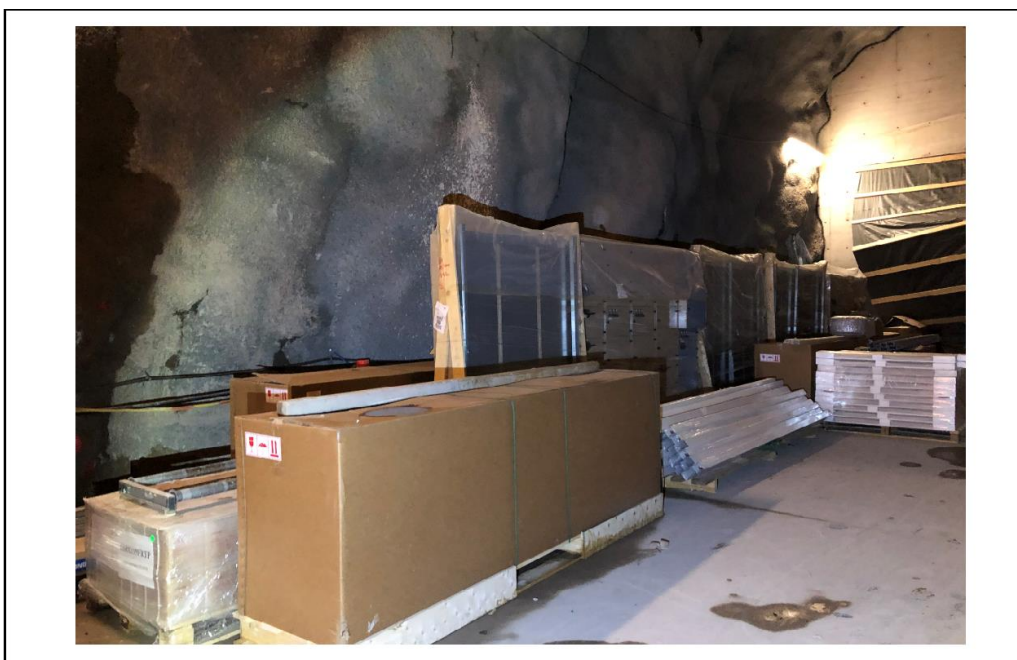
Kuva 9. Herkkiä sähkölaitteita on varastoitu maan alle ja suojattu oikeaoppisesti muoveilla
