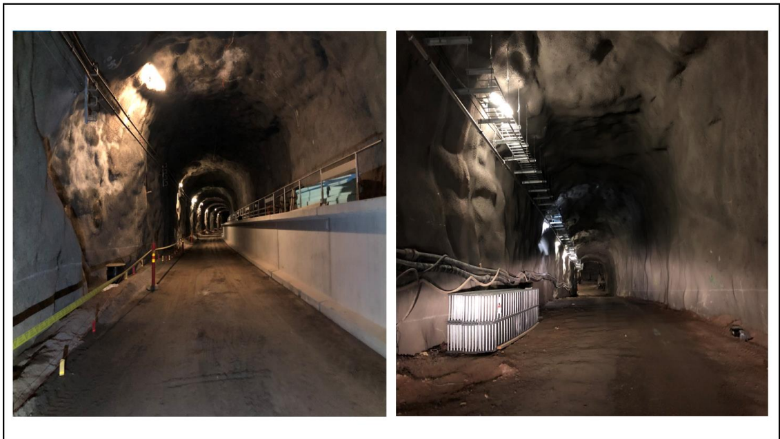
Kuva 8. Vasemmanpuoleisessa kuvattuna ratatunneli ja oikeanpuoleisessa kuvattuna huoltotunneli.
