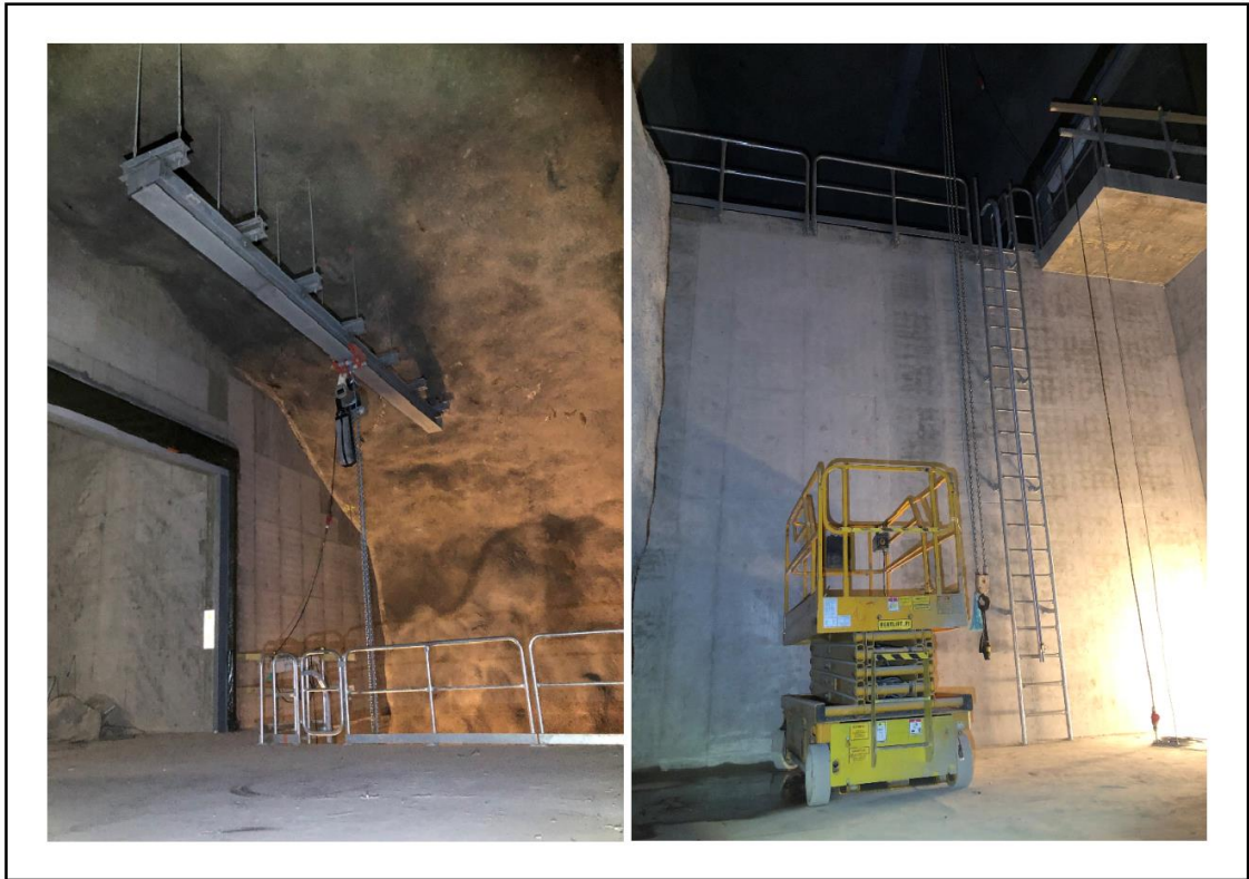
Kuva 21. Kohdetyömaan yksi useista sähkövinsseistä, jonka avulla voidaan nostaa raskaita kuormia kerrosten välillä
