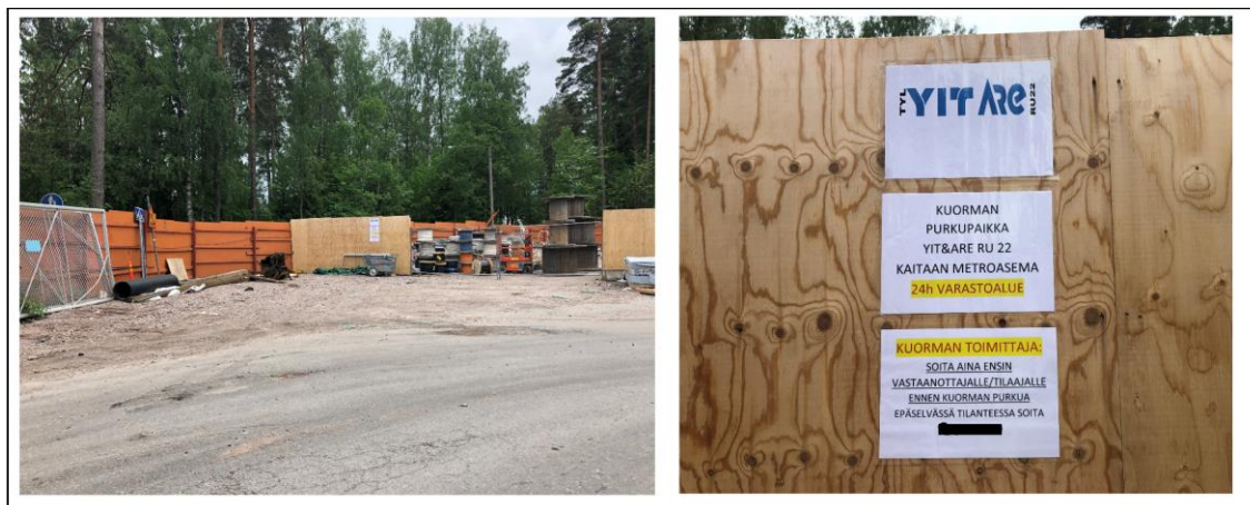
Kuva 11. Tunnelin suuaukon 24H varastoalue
