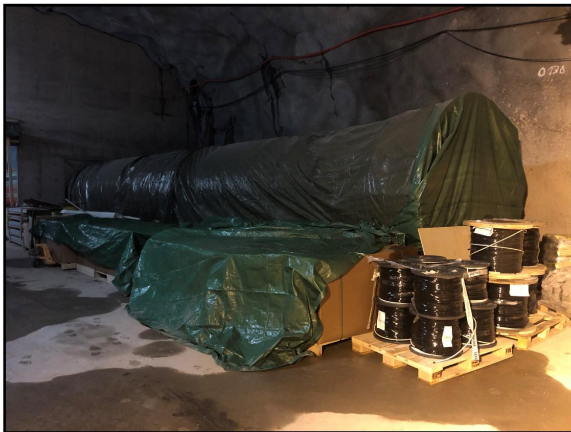
Kuva 27. Rakennusmateriaalit suojattu kivipölyltä ja tippuvedeltä.
