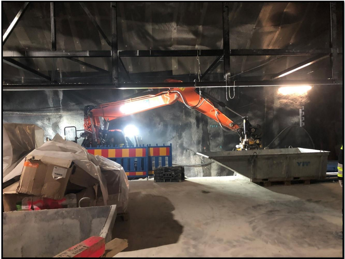
Kuva 2. Kaivinkone nostamassa tyhjät roska-astiat kuorma-auton kyydistä laiturialueelle, ja tämän jälkeen nostaa täydet roska-astiat kuorma-auton lavalle kuljetettavaksi maan pinnalle.
