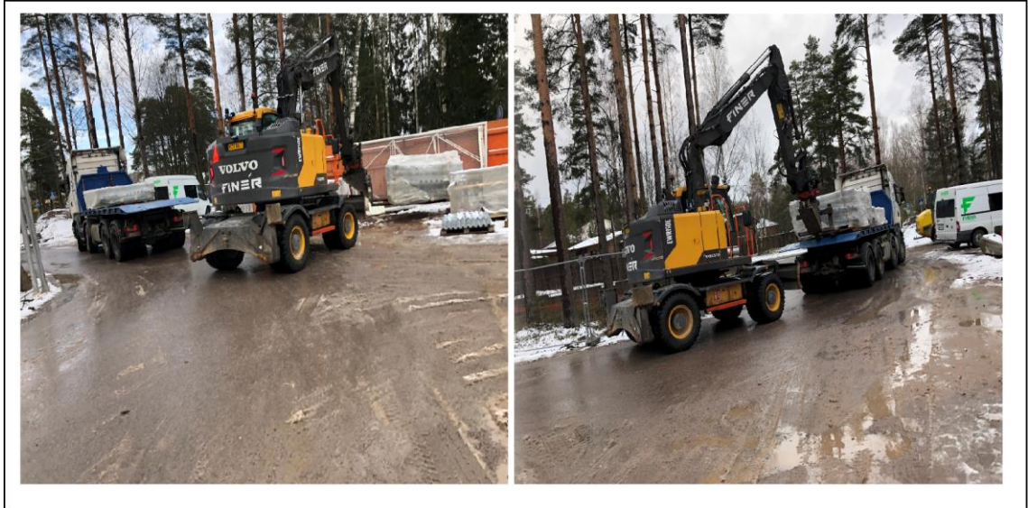
Kuva 22. Ovikuorma on toimitettu 24h varastoalueelle, josta se siirretään pyörialustaisen kaivinkoneen avulla kuorma-auton lavalle.
