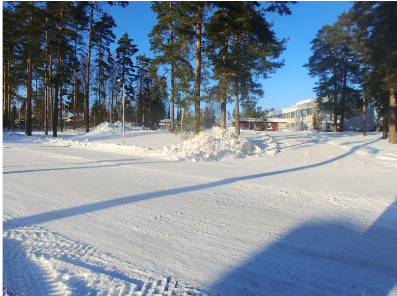
Kuva 31. Talvisin risteysalueilla olevat lumikasat muodostavat haitallisen näkemäesteen.
