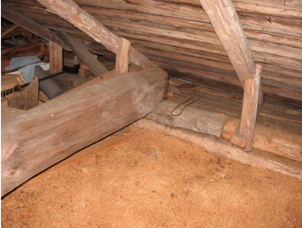
KUVA 9. Yläpohja vaikuttaa hyväkuntoiselta
