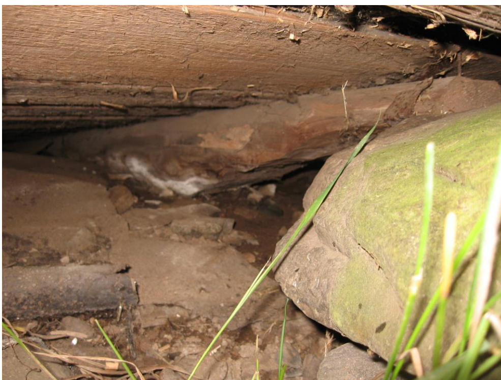
KUVA 5. Alapohjan kannatin ja ryömintätila
