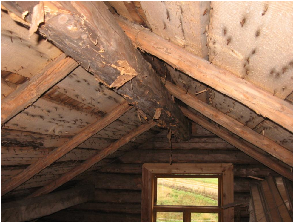
KUVA 10. Vesikaton kantavat rakenteet ovat kunnossa
